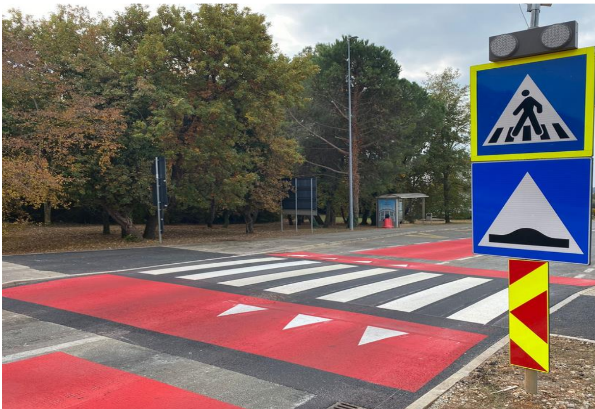
Slika 41. Uzdignuta ploha kolnika i obilježeni pješački prijelaz
