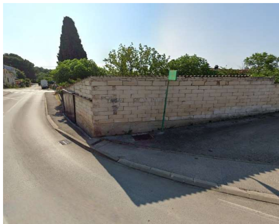
Slika 55. Pogled na nogostup na prometnici Ulica Josipa Brunjaka [16]
