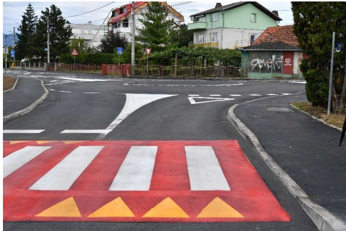
Slika 69. Uzdignuti pješački prijelaz u ulici Brestovačka [17]
