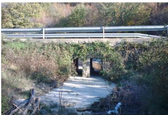
Slika 181. Cestovni propust (pc1)
