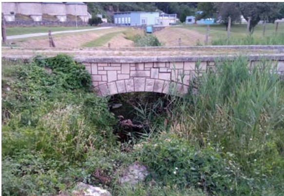
Slika 40. Cestovi propust (pc2)
