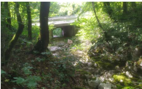
Slika 128. Cestovni propust (pc2)
