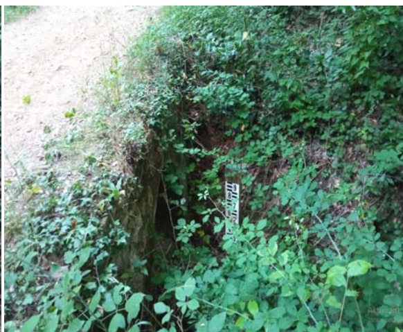
Slika 77. Cestovni propust (pc1)
