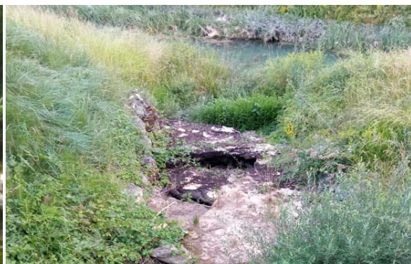
Slika 129. Utok u kanal
