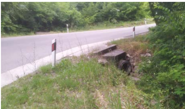
Slika 126. Cestovni propust (pc1)
