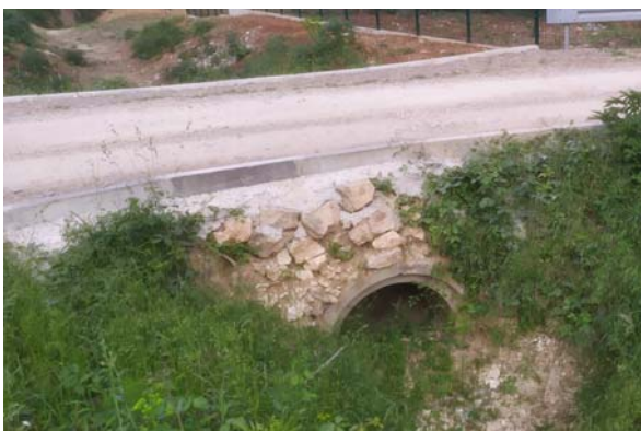
Slika 47. Cestovni propust (pc1)
