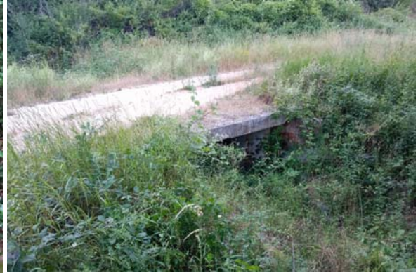
Slika 61. Cestovni propust (pc1)
