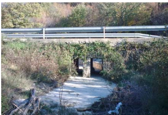
Slika 181. Cestovni propust (pc1)
