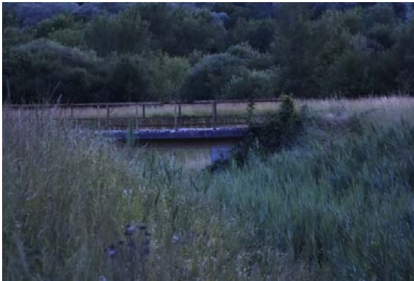
Slika 103. Cestovni propust (pc1)
