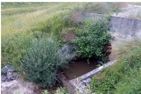
Slika 137. Cestovni propust i utok u OK1
