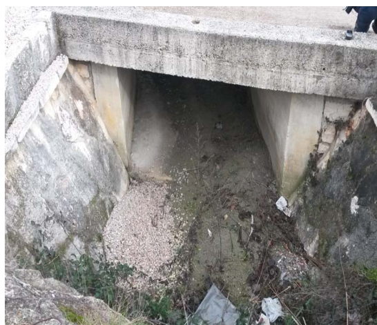
Slika 160. Cestovni propust (pc1)
