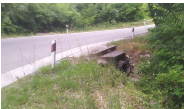
Slika 126. Cestovni propust (pc1)
