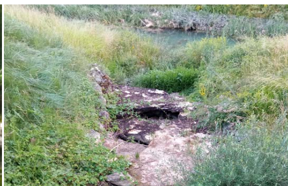
Slika 129. Utok u kanal
