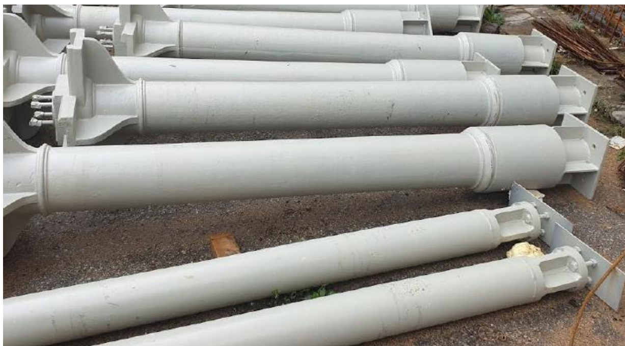
Slika 23: Tipični riječki lijevanoželjezni stupovi nakon reparacije sa gradilišta Rikard Benčić u Rijeci
