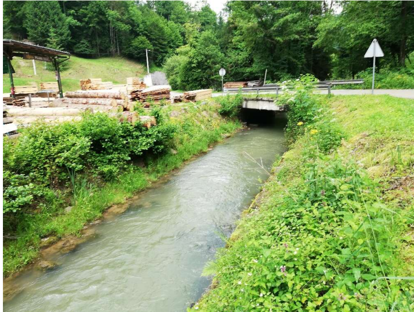
Slika 9 Propust ceste ŽC 5185 [6]
