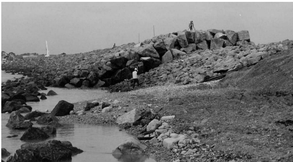
Slika 13 Kameni obalni nasip tijekom izgradnje (The Rock Manual, 2007)
