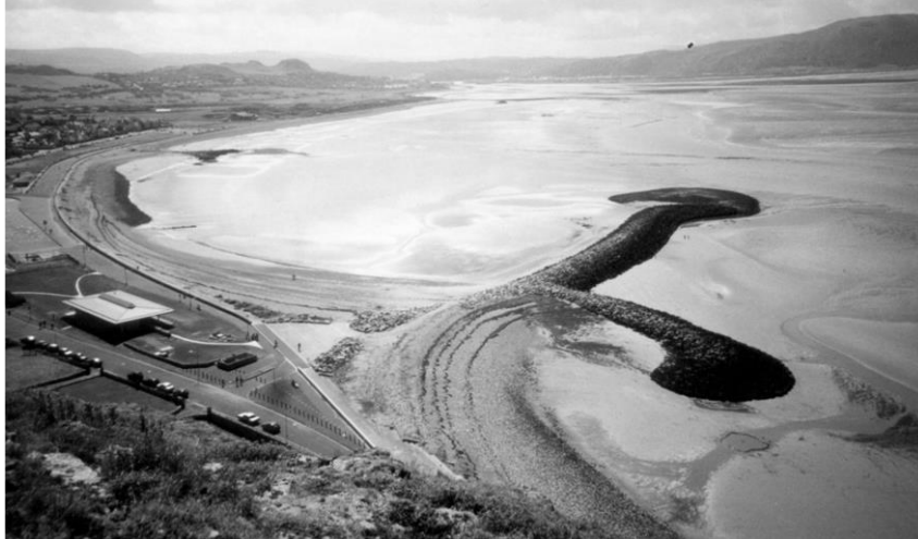
Slika 16 Pera u obliku ribljeg repa (The Rock Manual, 2007)
