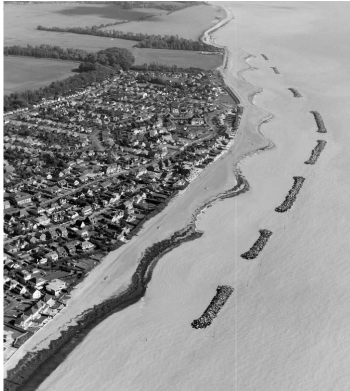
Slika 15 Odvojeni lukobrani uz plažu (The Rock Manual, 2007)
