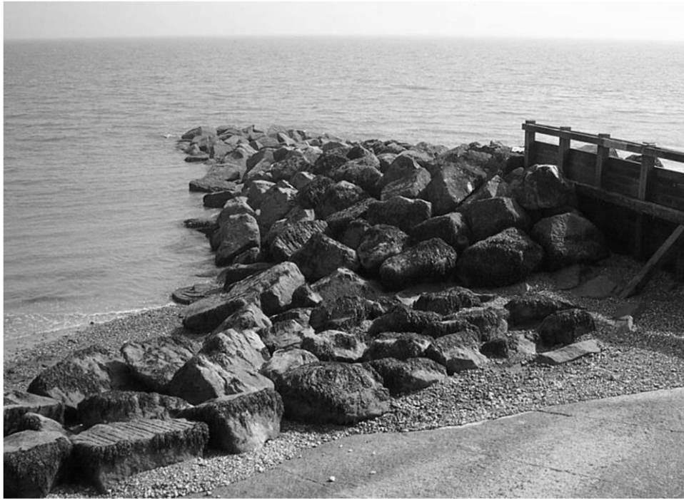
Slika 14 Kameno pero (The Rock Manual, 2007)
