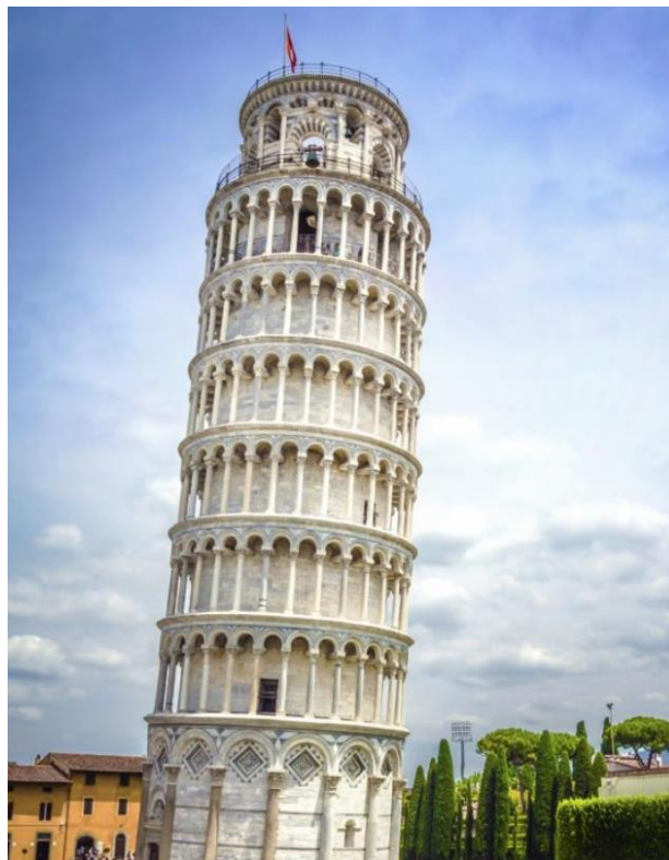
Slika 2:Kosi toranj u Pisi; diferencijalno slijeganje [2]
