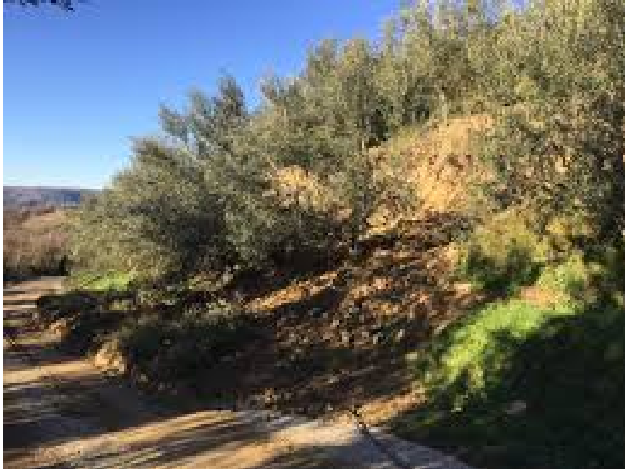
Slika 2.9: Klizište u selu Flegi, općina Motovun [4]
