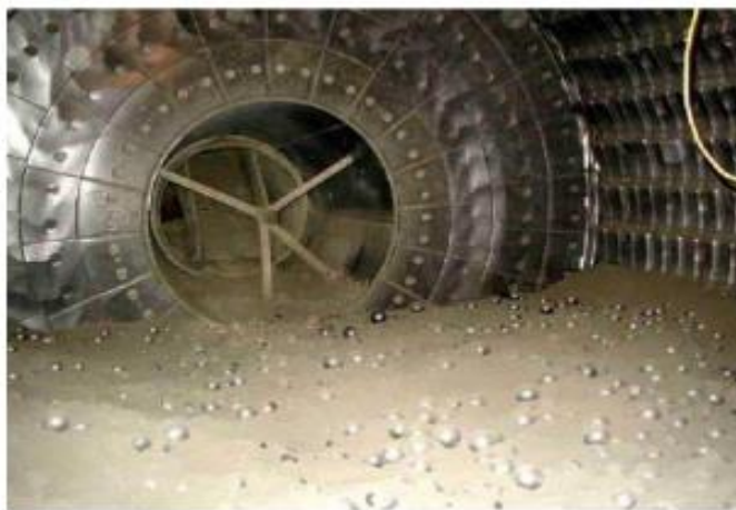
Slika 4. Mljevenje klinkera, unutrašnjost mlina s kuglama [1]
