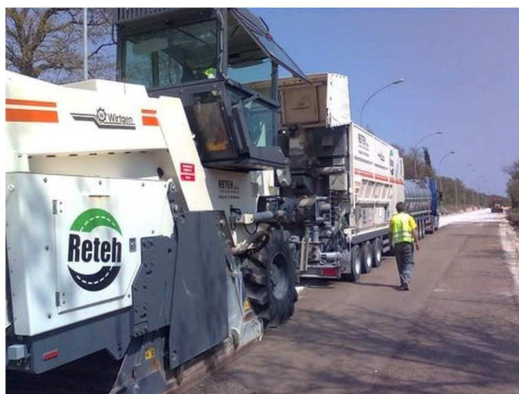
Slika 14: Vlak s više jedinica na gradilištu [8]
