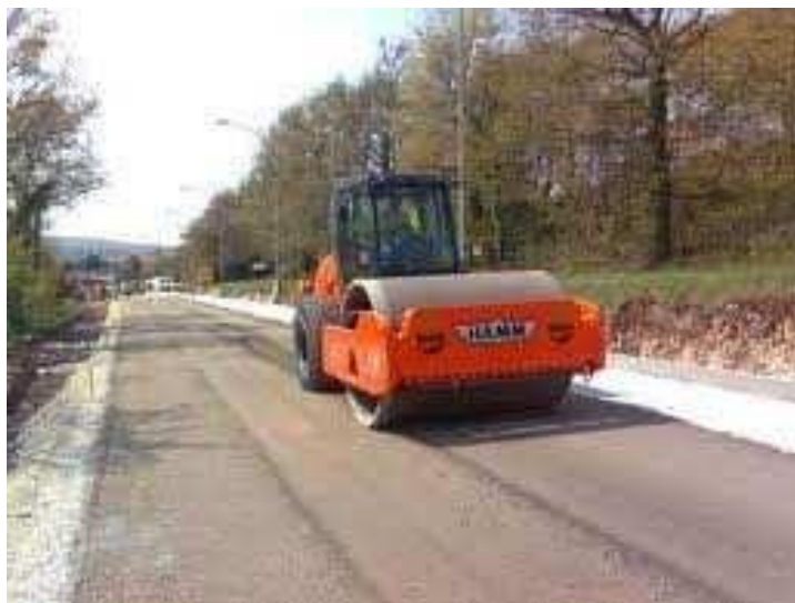
Slika 15. Valjak za mehaničko zbijanje
