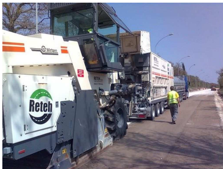
Slika 14: Vlak s više jedinica na gradilištu [8]
