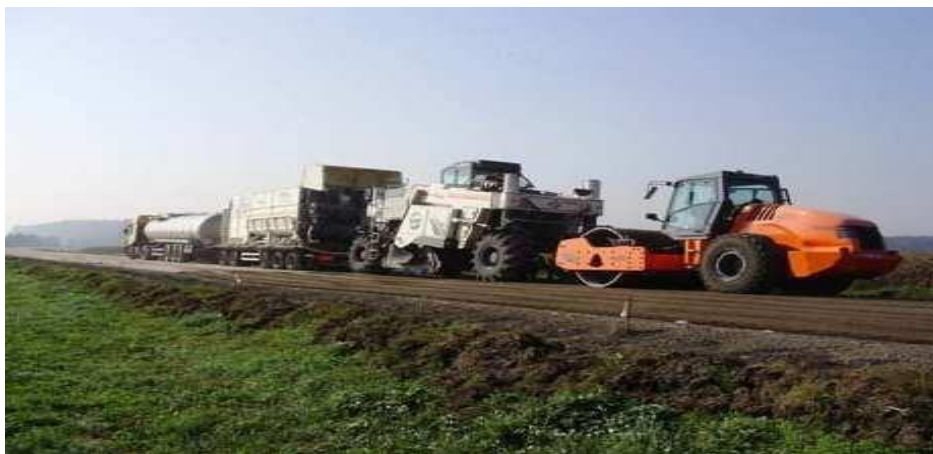
Slika 21: Tehnologija ugradnje na gradilištu [8]
