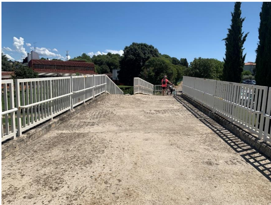
Slika 70: Hodna ploha mosta u Prvomajskoj ulici
