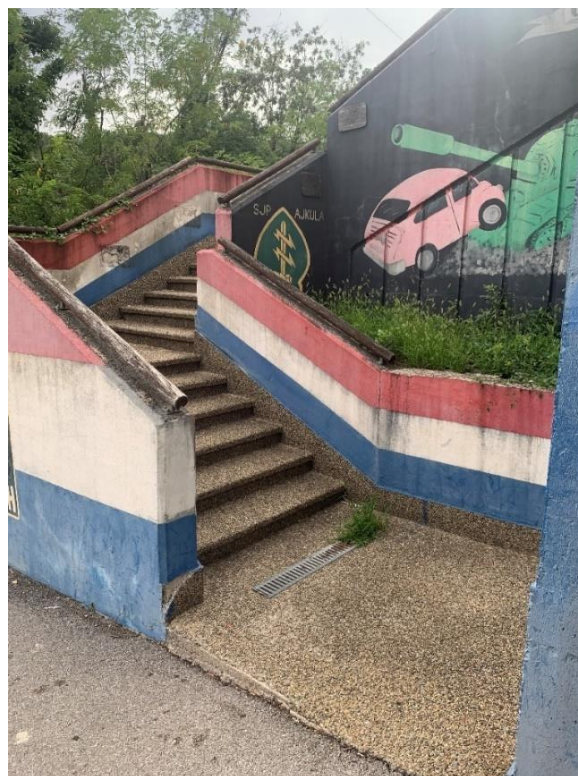
Slika 52: Stubište sa strane ceste
