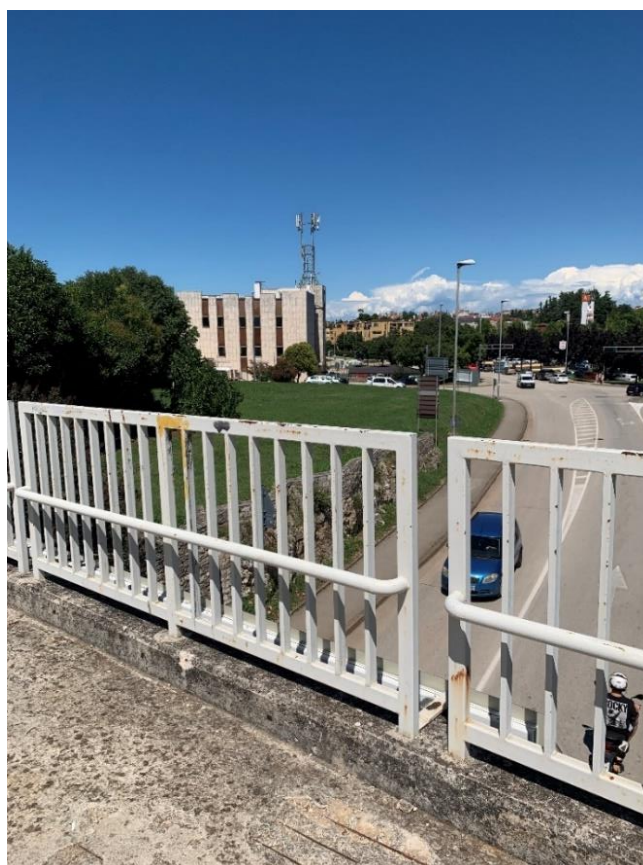
Slika 72: Ograda i rukohvat mosta u Prvomajskoj ulici
