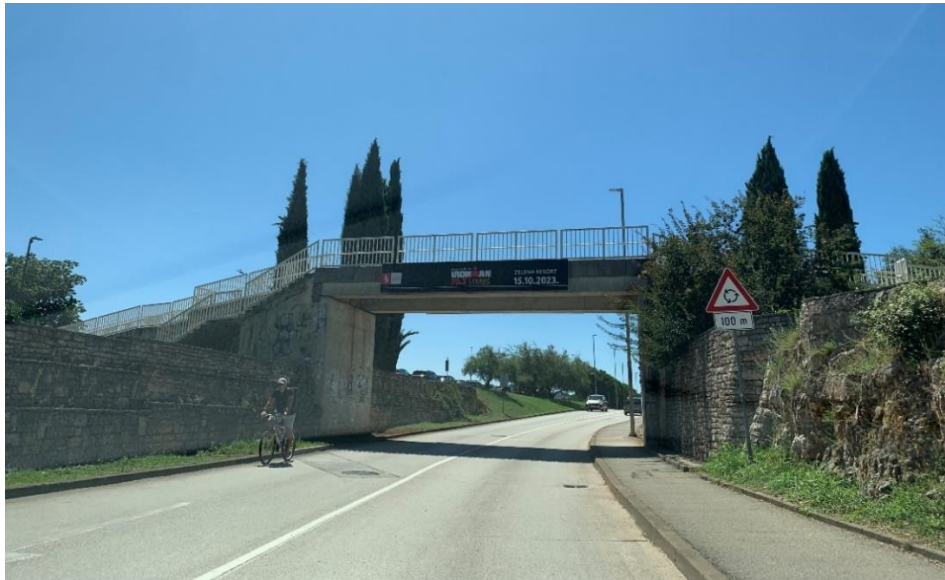
Slika 69: Konstrukcija mosta u Prvomajskoj ulici
