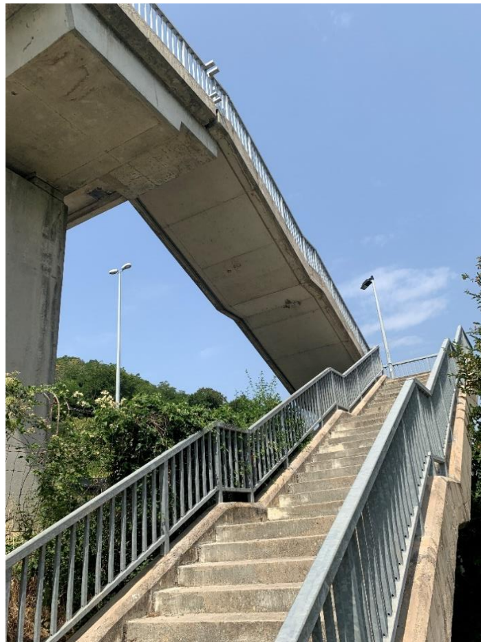
Slika 58: Stubište mosta iznad Kvarnerske Autoceste
