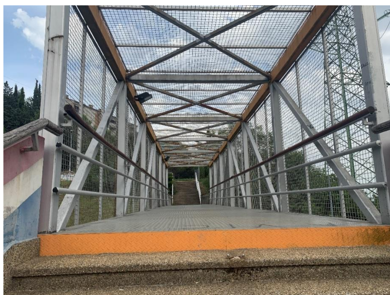
Slika 54: Prikaz stube visine 18,5 cm
