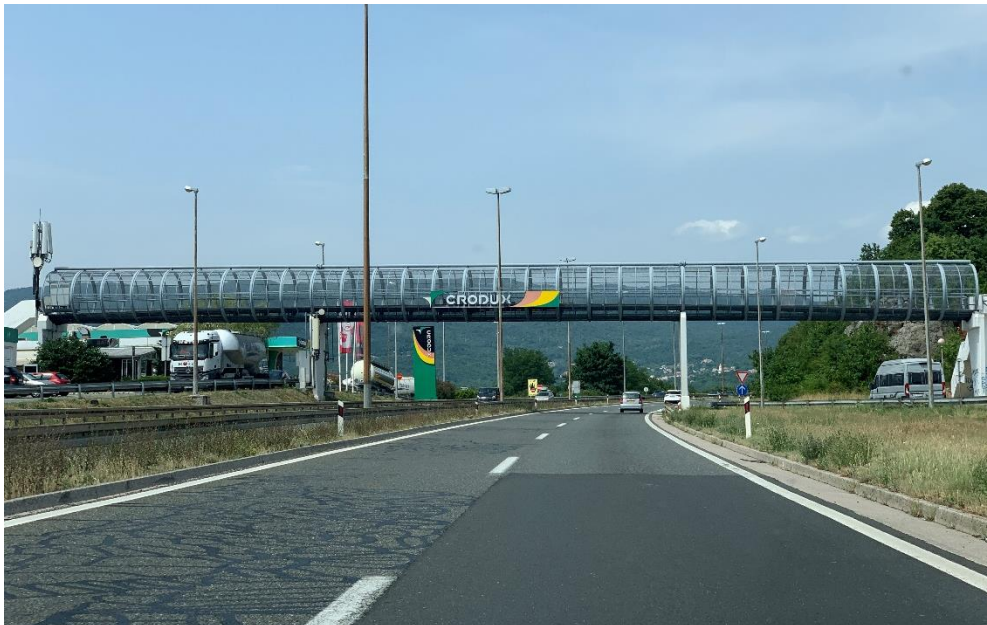
Slika 45: Konstrukcija mosta Vrata Jadrana
