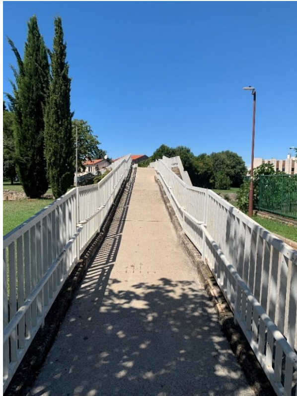
Slika 74: Rampa mosta u Prvomajskoj ulici
