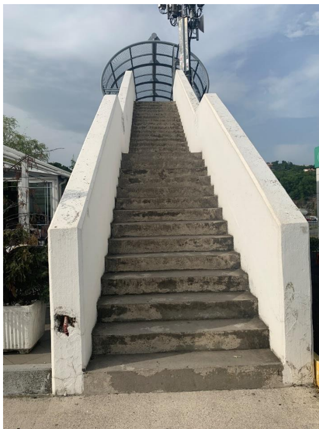
Slika 48: Stubište mosta Vrata Jadrana
