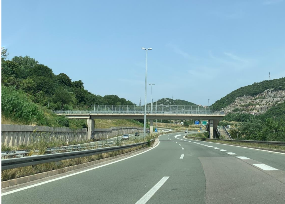
Slika 55: Konstrukcija mosta iznad Kvarnerske Autoceste
