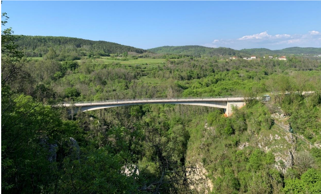
Slika 64: Konstrukcija mosta Vršič
