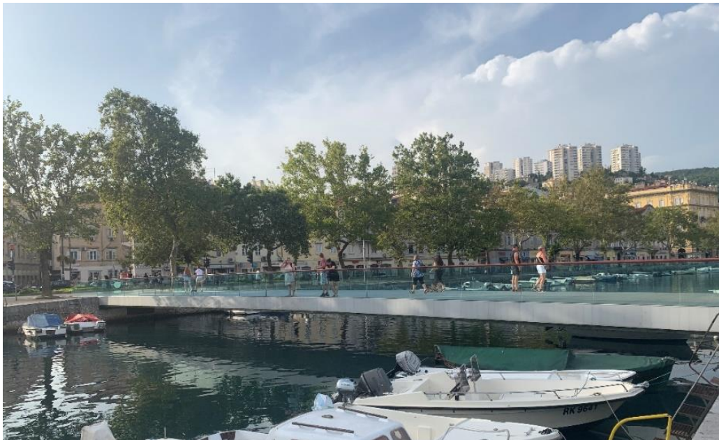
Slika 60: Konstrukcija Mosta hrvatskih branitelja iz Domovinskog rata
