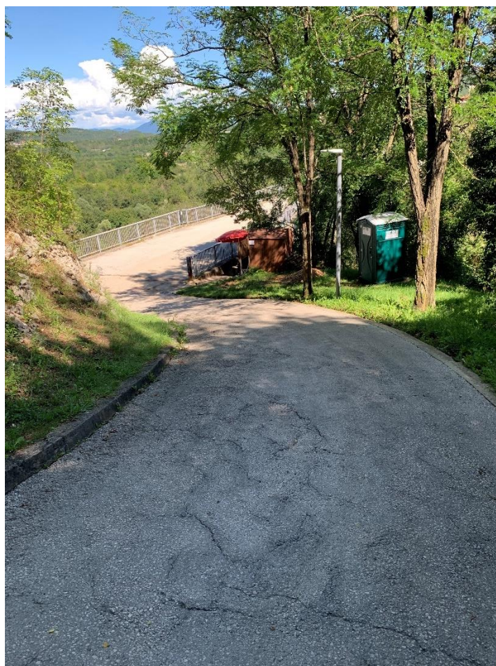
Slika 68: Pristupna cesta mosta Vršić
