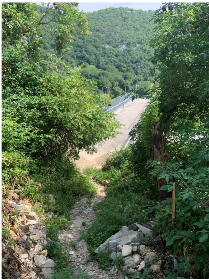
Slika 59: Pristupni put mosta iznad Kvarnerske Autoceste
