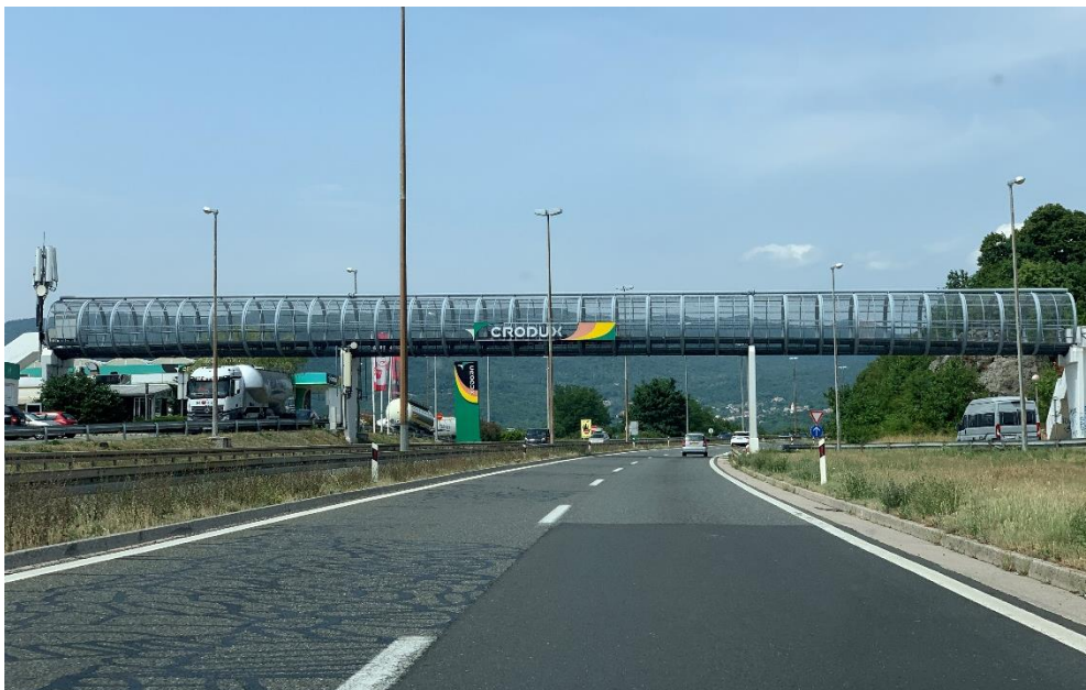
Slika 45: Konstrukcija mosta Vrata Jadrana
