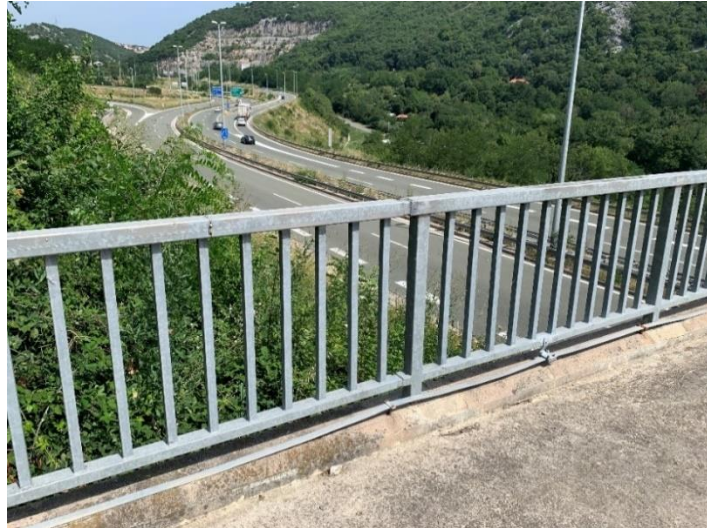
Slika 57: Ograda i rukohvat mosta iznad Kvarnerske Autoceste
