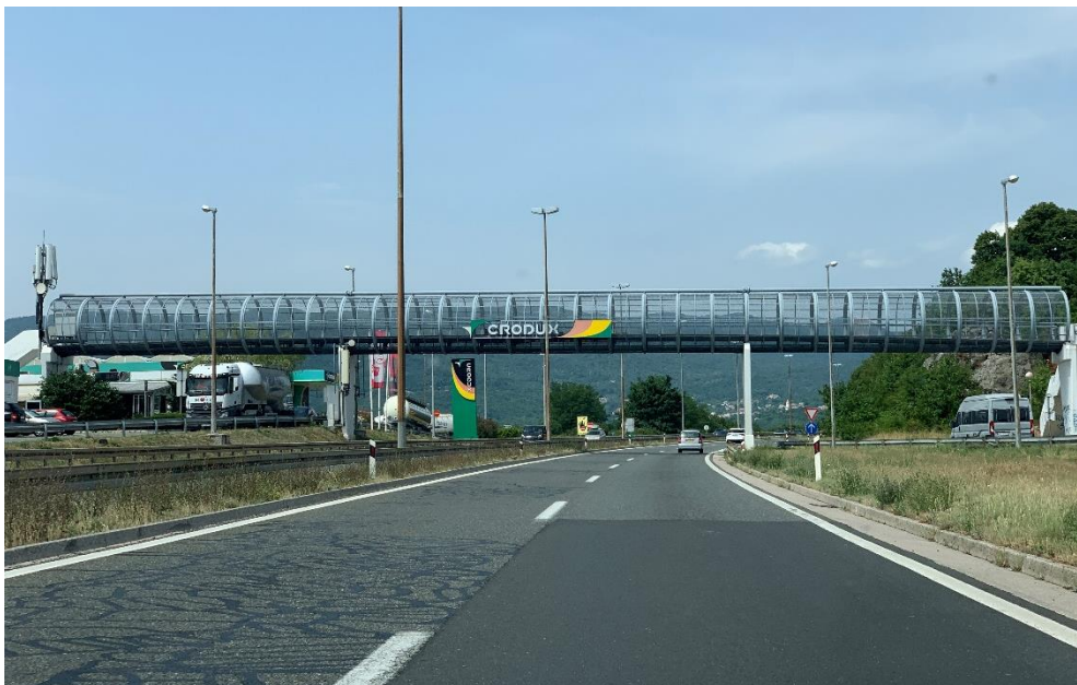
Slika 45: Konstrukcija mosta Vrata Jadrana
