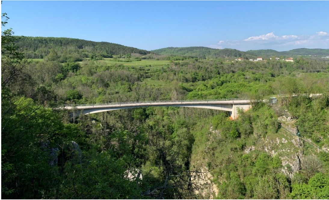
Slika 64: Konstrukcija mosta Vršič
