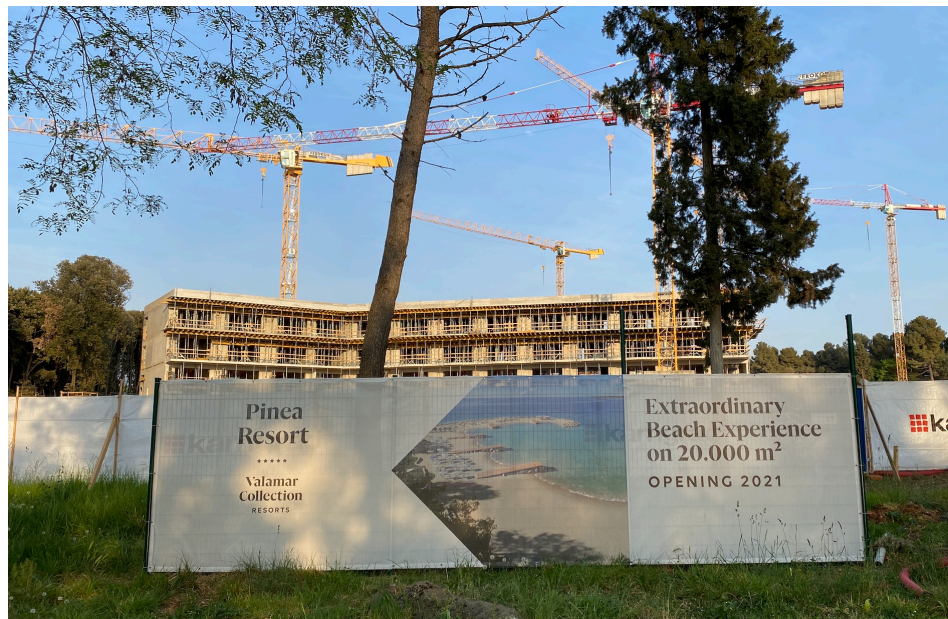
Slika 24: Pogled na gradilište Hotela Pinea (Izradio autor)
