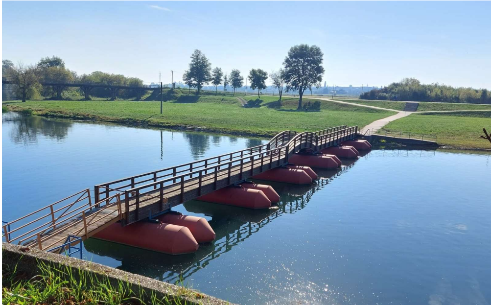
Slika 13 Pješački pontonski most, izvor: fotografija autorice
