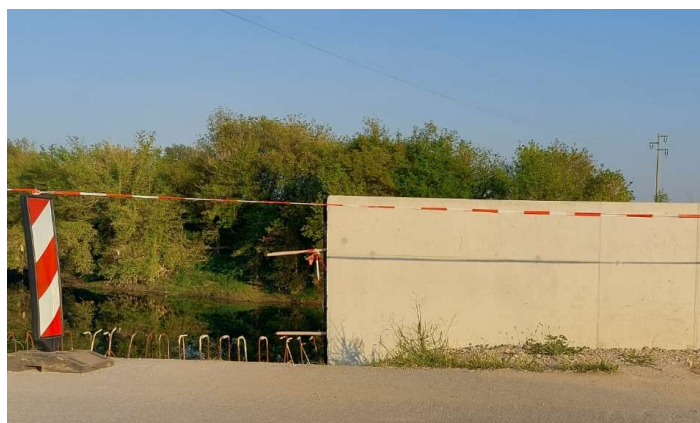
Slika 8 Izgradnja armiranobetonskog zaštitnog zida u ulici Selce, izvor: fotografija autorice
