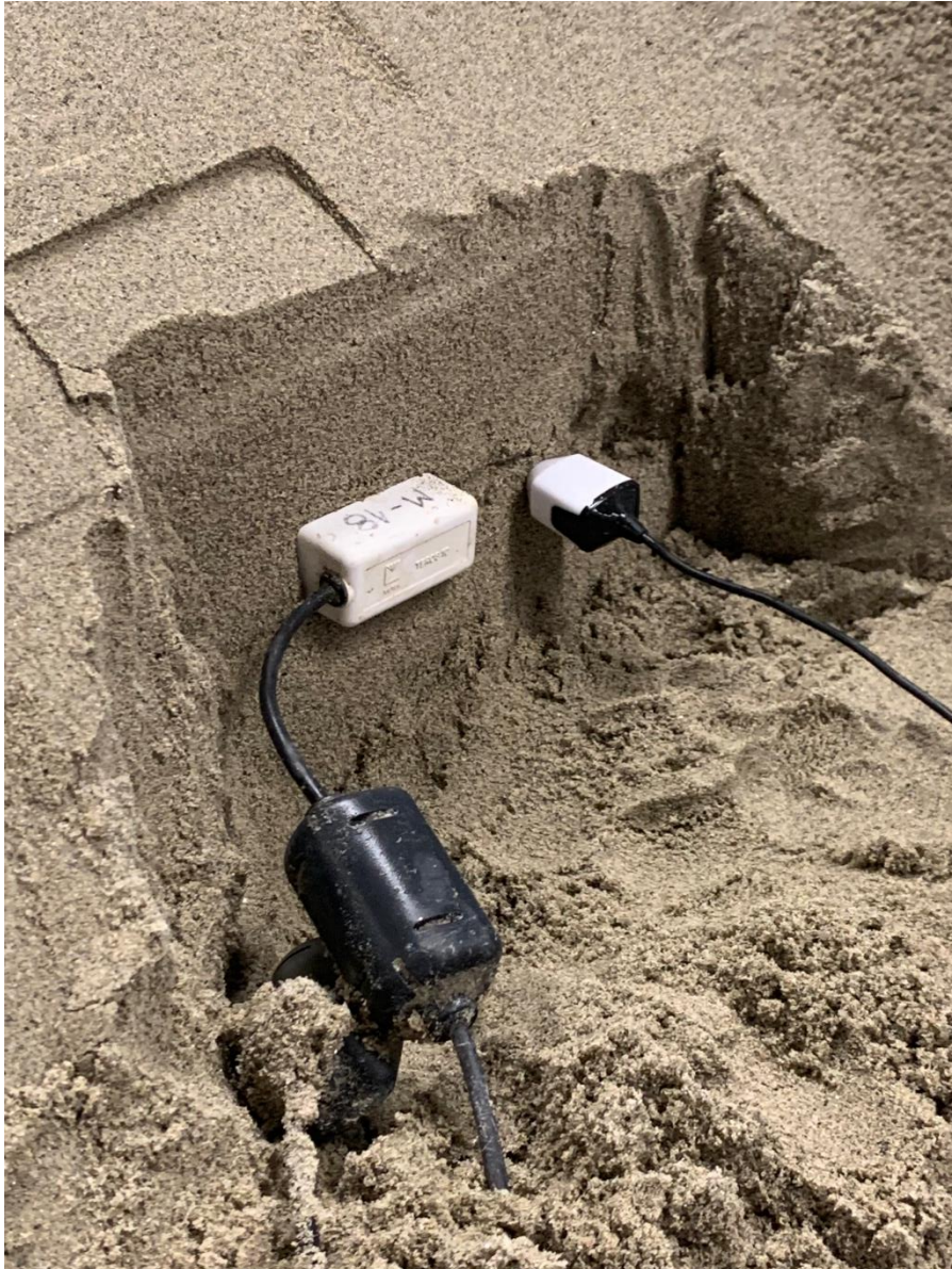
Slika 11. Ugrađeni uređaji za mjerenje pornih pritisaka i vlažnosti.
