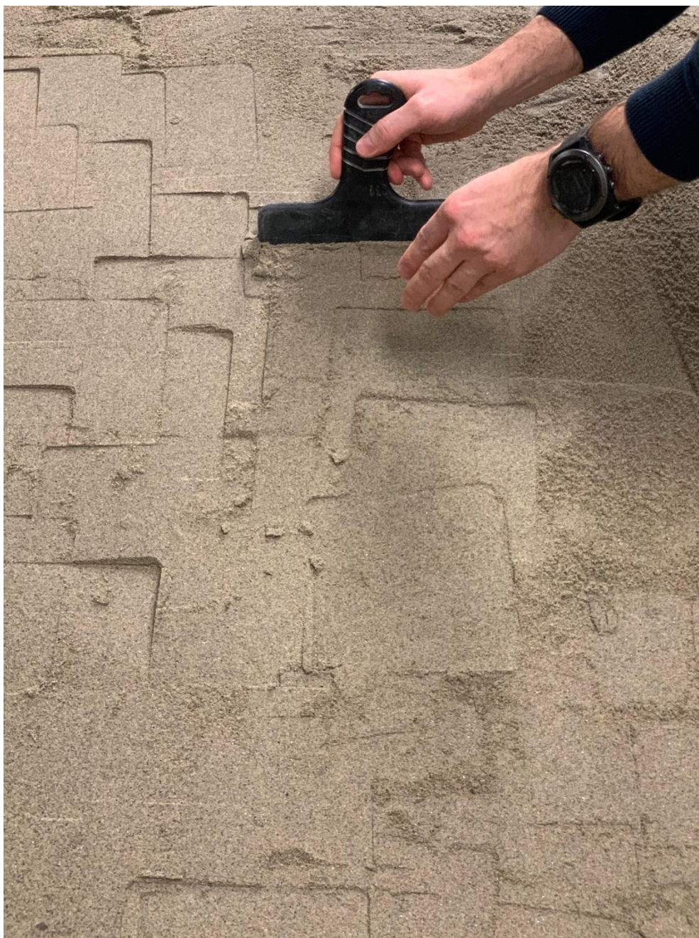
Slika 10. Postupak zasijecanja materijala prilikom ugradnje senzora.
