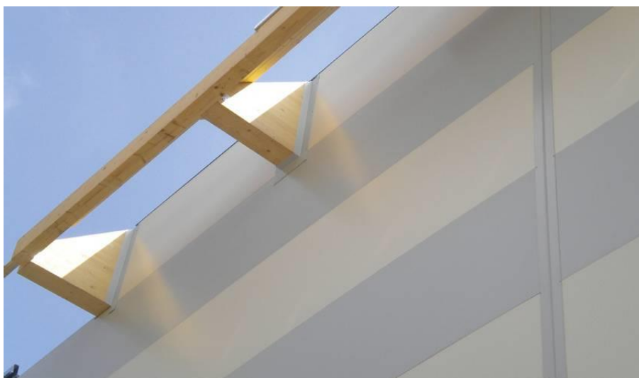
Slika 2. Fasadni pokrov - Izoforma Isopar elegant sendvič panel [1]
