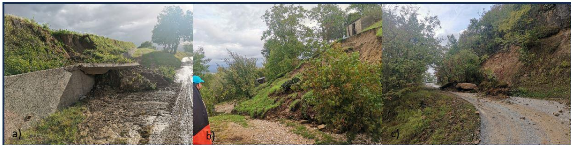
Slika 12 a) b) i c) translacijsko klizanje površinskih naslaga
