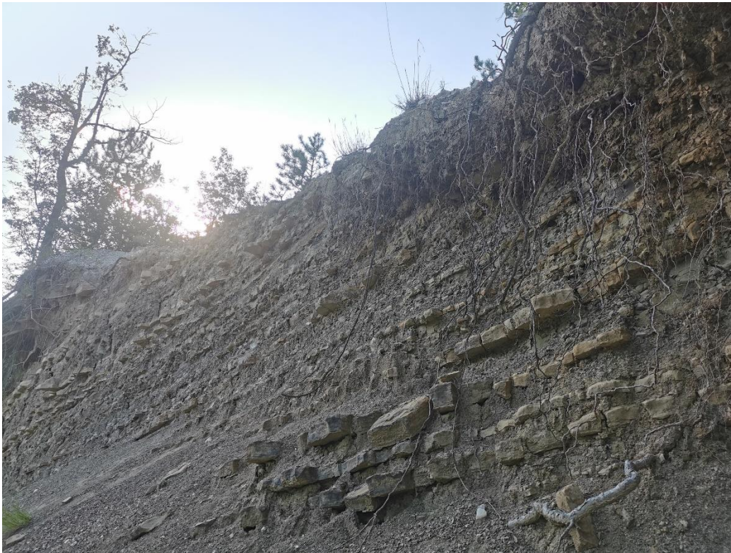
Slika 14 Slojevi pješčenjaka i lapora na lokaciji klizišta (foto: L.Vuksan, kolovoz 2023)
