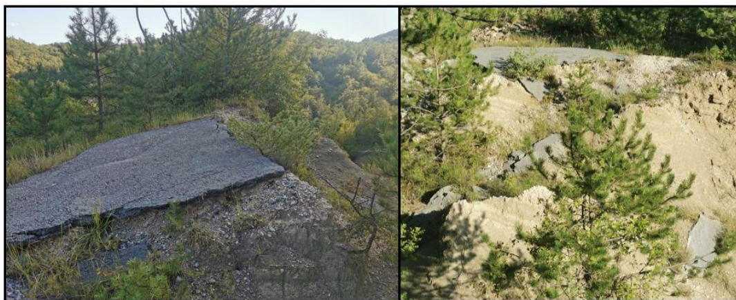
Slika 16 Ostaci lokalne ceste (foto: L.Vuksan, kolovoz 2023)
