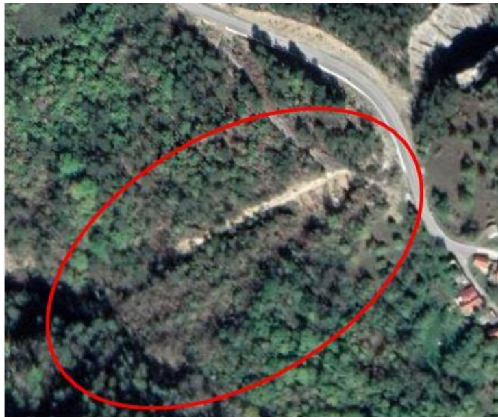
Slika 13 Pogled na klizište Brus (Preuzeto s Google Earth, 2022)
