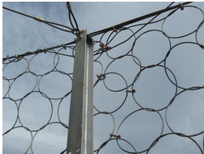
Slika 47. Mreža čeličnih prstenova [35]
