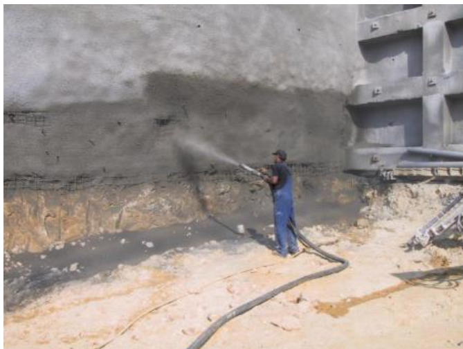
Slika 35. Nanošenje mlaznog betona na stijenski pokos [3]
