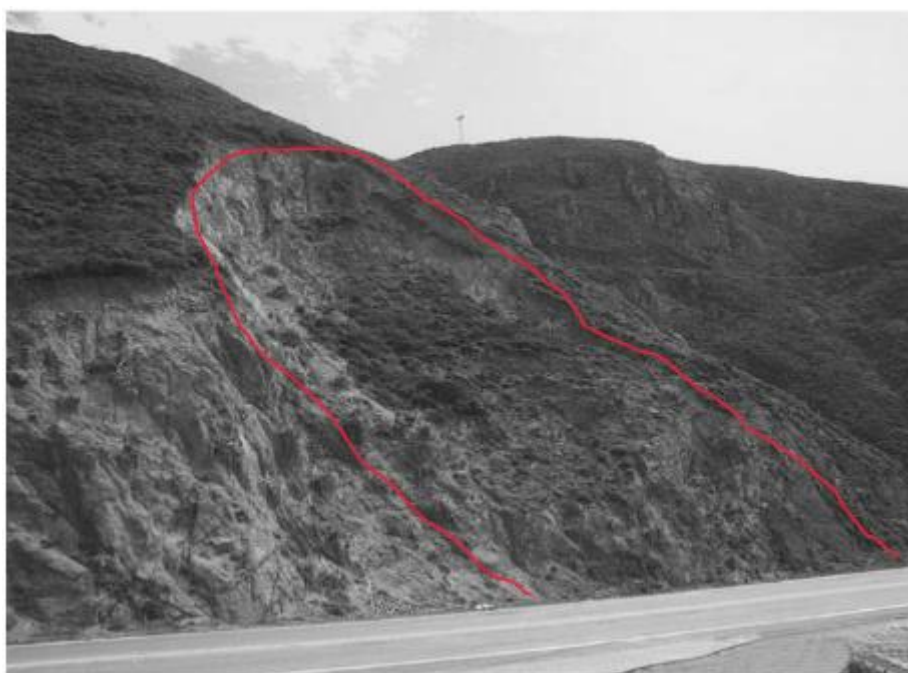
Slika 17. Kružni slom [2]
