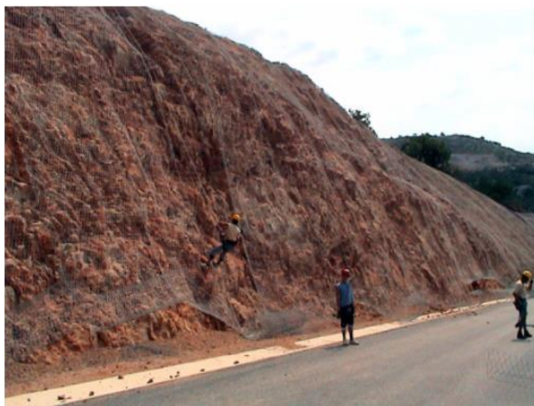
Slika 43. Zaštita pokosa dvostruko isprepletenim pocinčanim mrežama [32]
