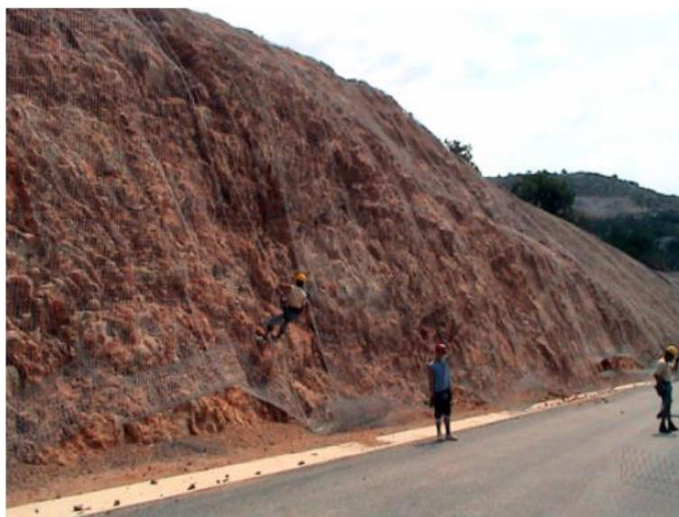
Slika 43. Zaštita pokosa dvostruko isprepletenim pocinčanim mrežama [32]
