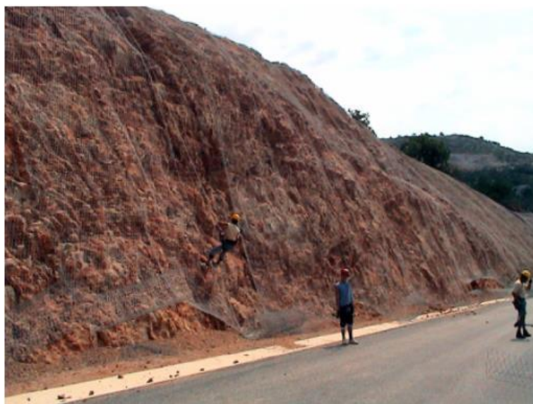
Slika 43. Zaštita pokosa dvostruko isprepletenim pocinčanim mrežama [32]
