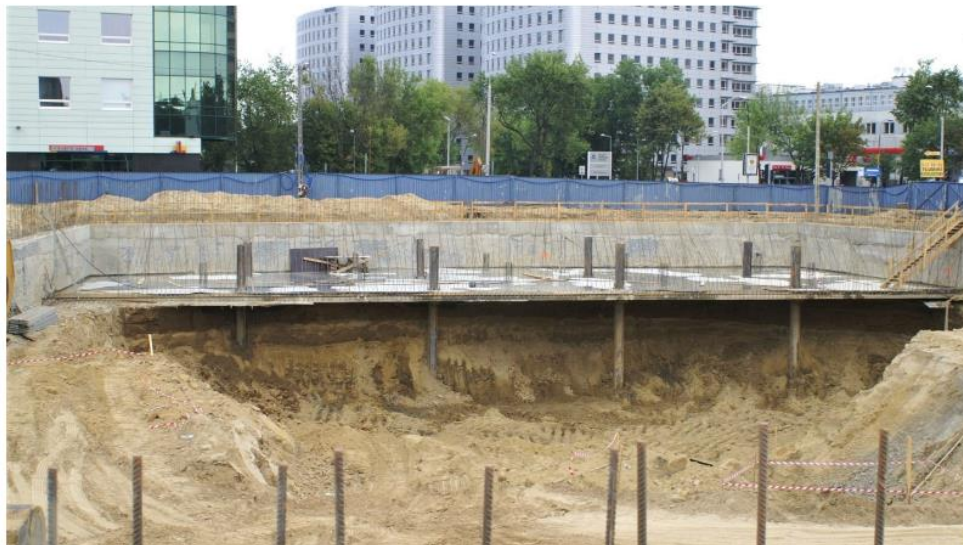
Slika 13: Osiguranje građevne jame top - down metodom [18]
