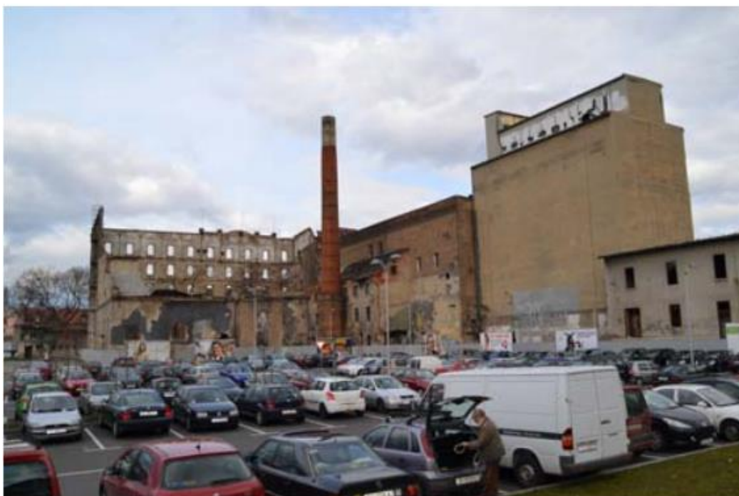
Slika 19: Postojeće stanje konstrukcije Paromlina [30]
