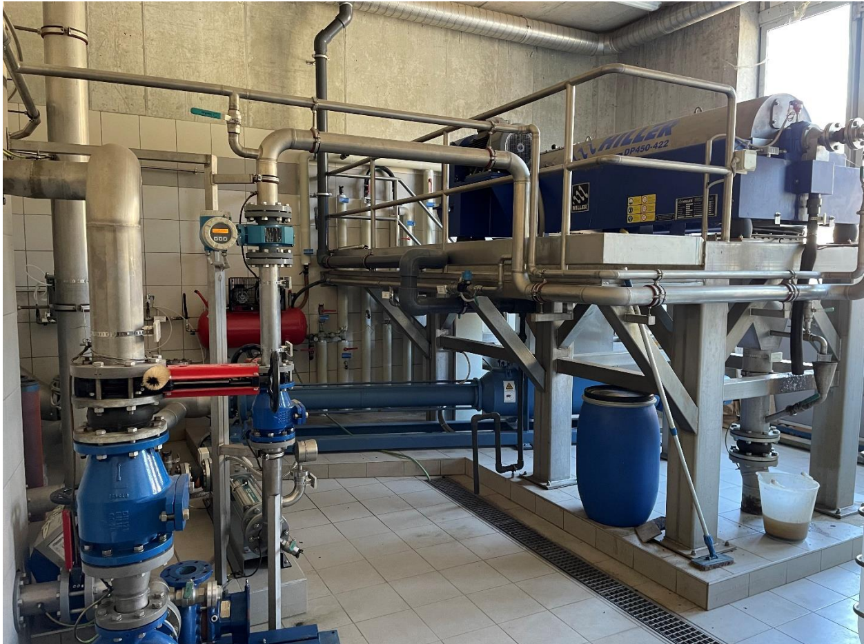
Slika 29. Postrojenje za dehidraciju mulja – centrifuga (vlastita fotografija)
