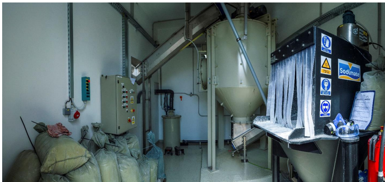
Slika 27. Kontaktni reaktor za stabilizaciju mulja (vlastita fotografija)
