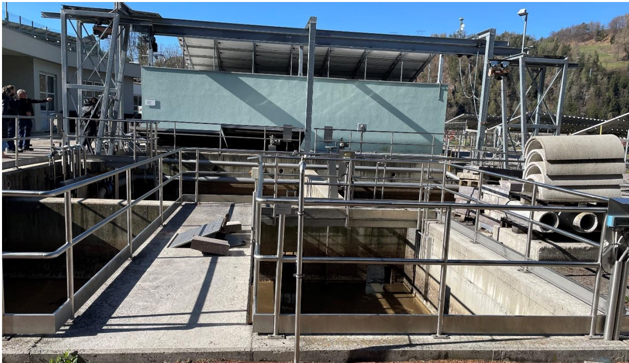
Slika 19. Bazen denitrifikacije (vlastita fotografija)
