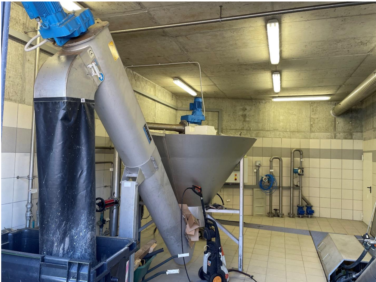
Slika 15. Klasifikator i ispirać pijeska (vlastita fotografija)
