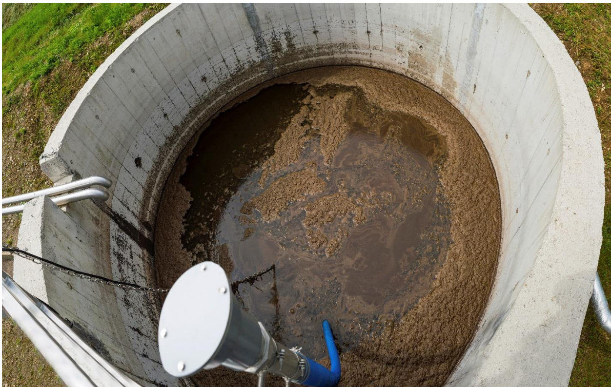
Slika 25. Spremnik viška mulja (vlastita fotografija)
