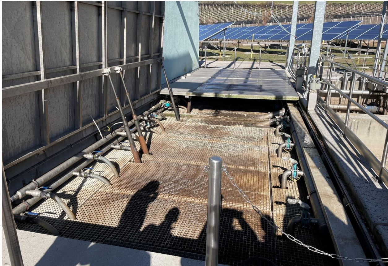
Slika 21. MBR bazeni (vlastita fotografija)
