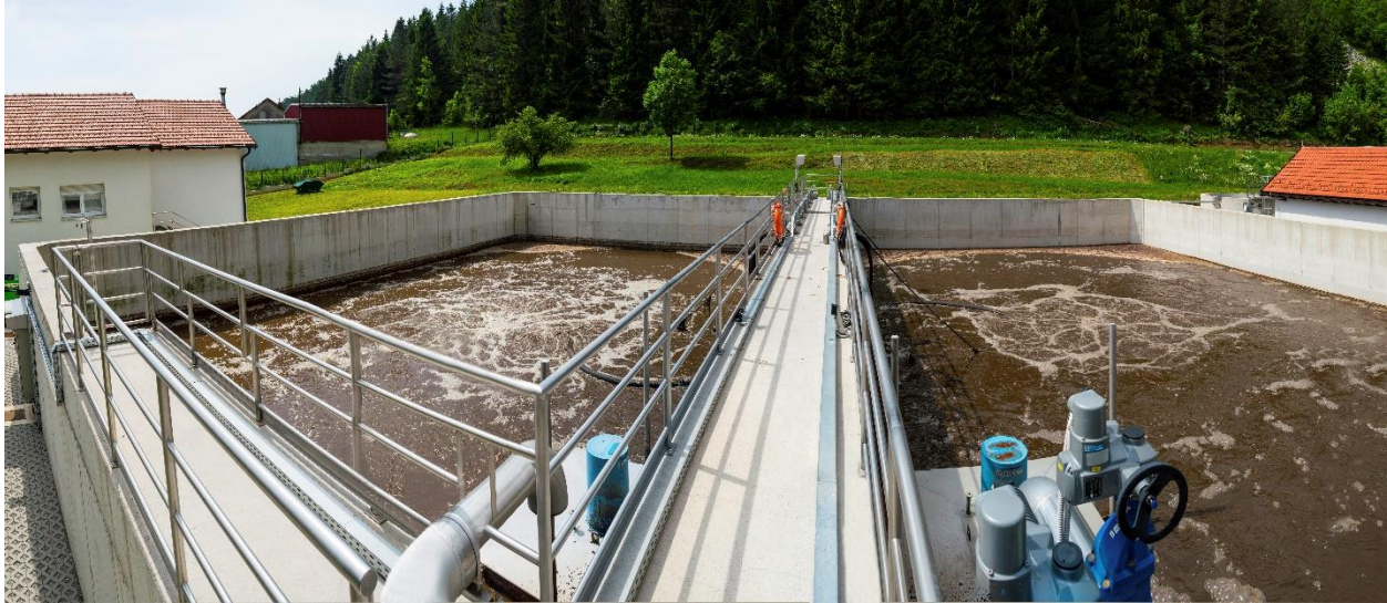
Slika 17. SBR reaktori (vlastita fotografija)
