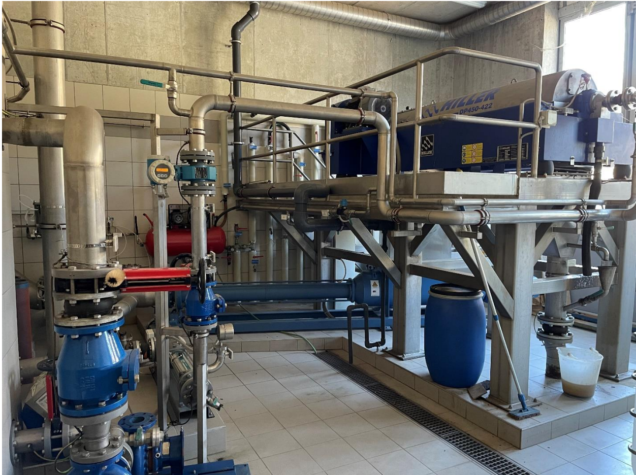
Slika 29. Postrojenje za dehidraciju mulja – centrifuga (vlastita fotografija)
