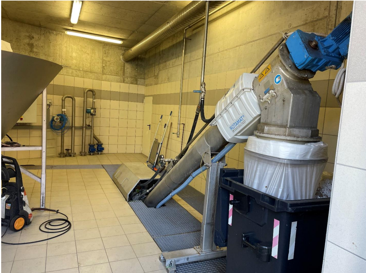
Slika 13. Fino sito (vlastita fotografija)
