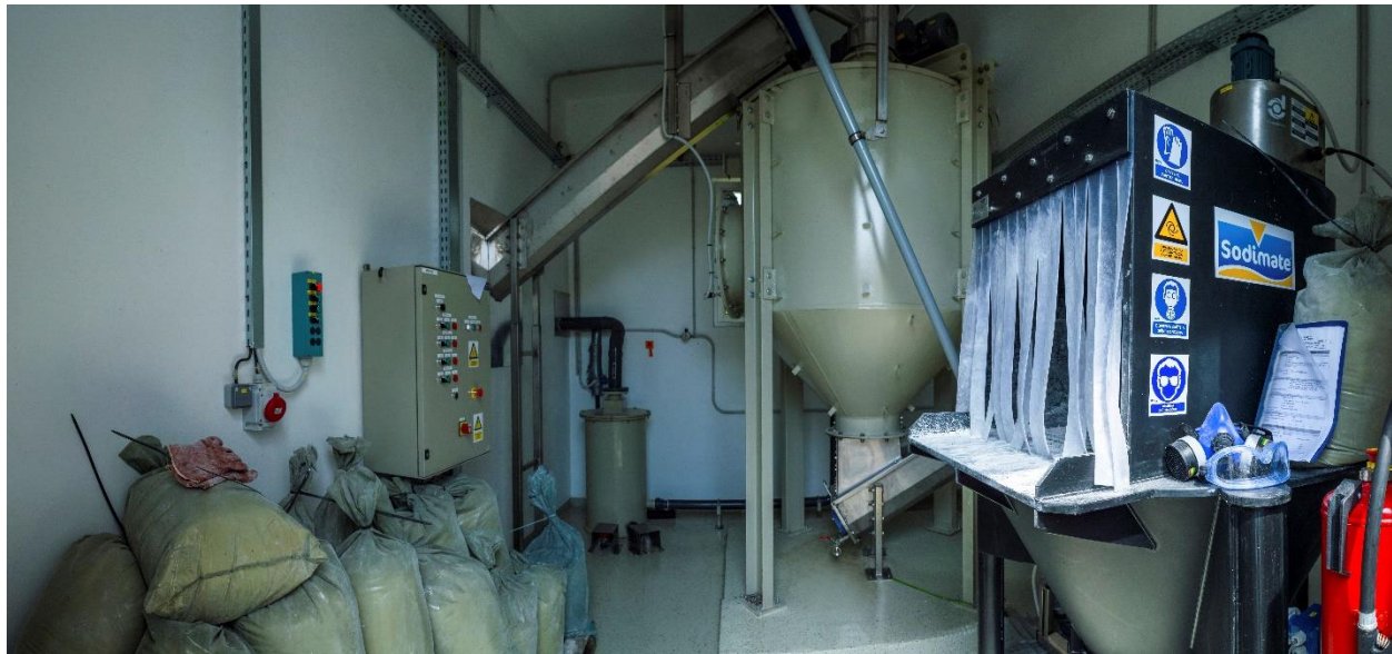
Slika 27. Kontaktni reaktor za stabilizaciju mulja (vlastita fotografija)
