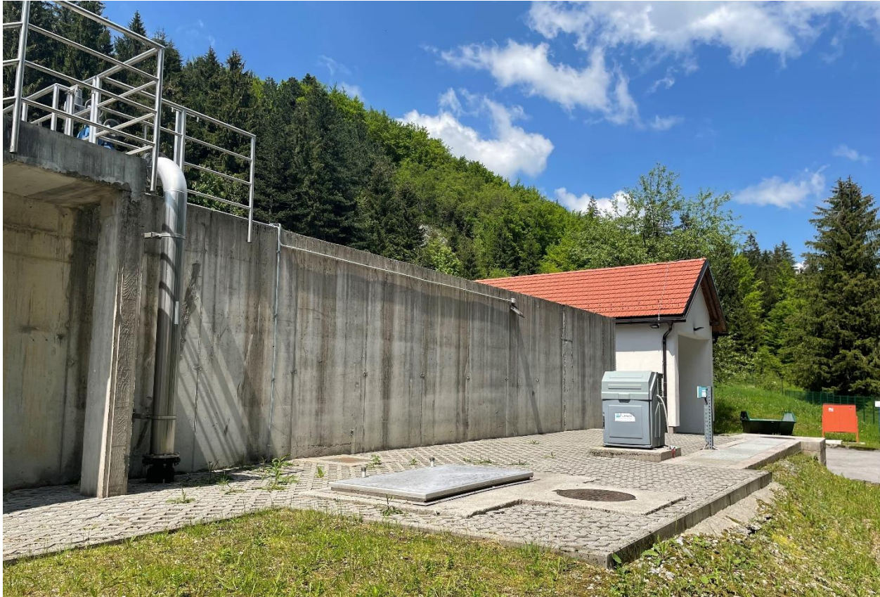
Slika 18. Automatski uzorkivač i Khafagi – Venturi mjerni kanal (vlastita fotografija)
