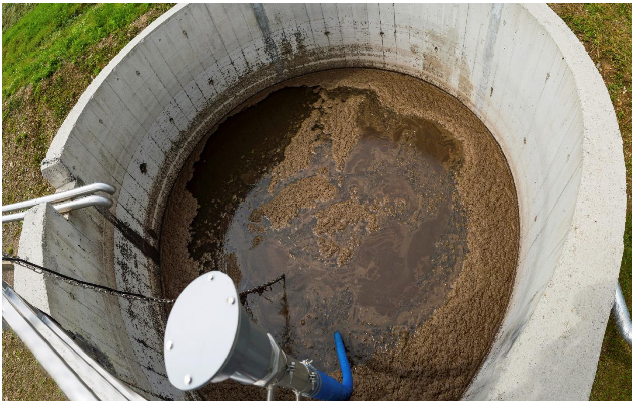
Slika 25. Spremnik viška mulja (vlastita fotografija)
