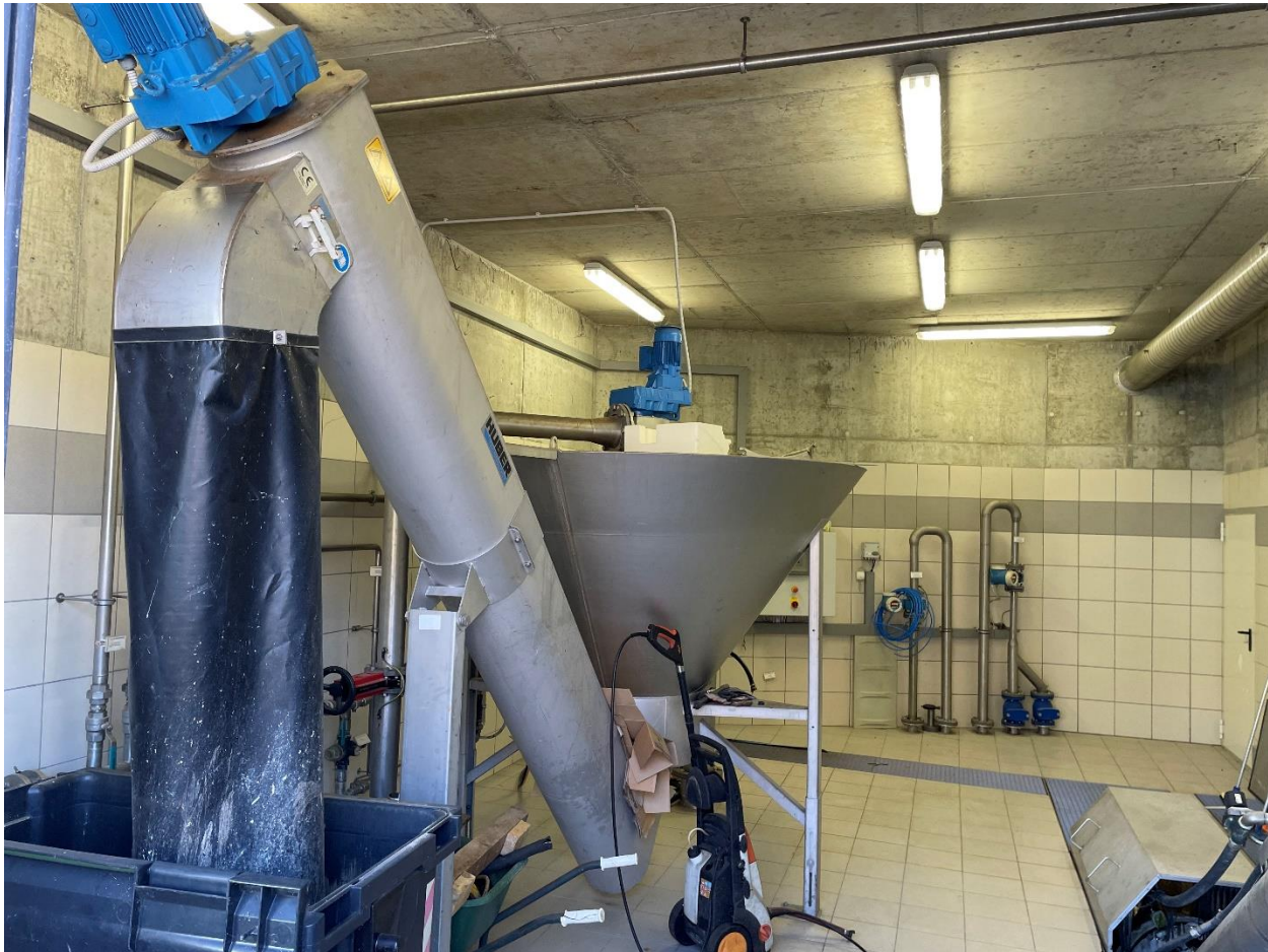
Slika 15. Klasifikator i ispirač pijeska (vlastita fotografija)
