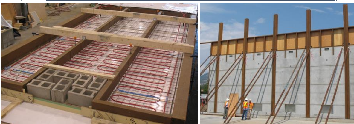
d) Zidni TCC paneli s ugrađenim sustavom grijanja – proizvodnja i ugradnja (izvor: https://structurecraft.com/projects/okanagan-college-gym-wall-panels )
