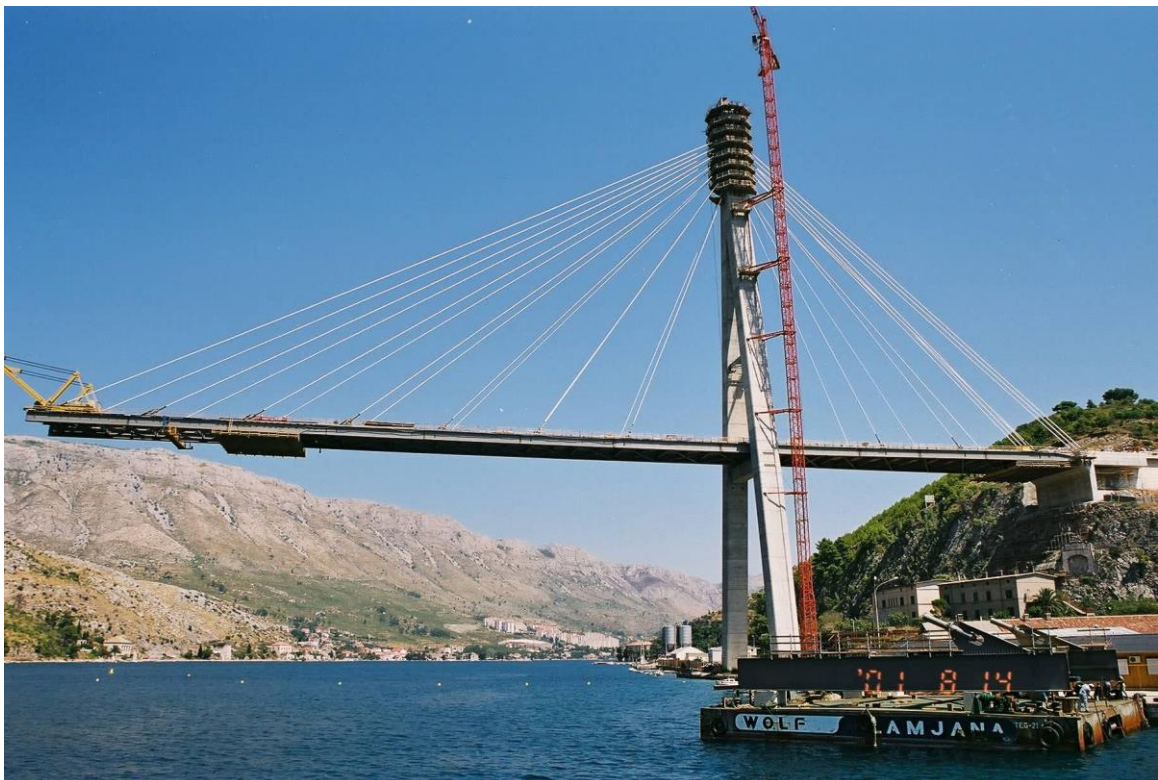
Slika 3: Ovjlašeni spregnuti sklop u fazi gradnje
