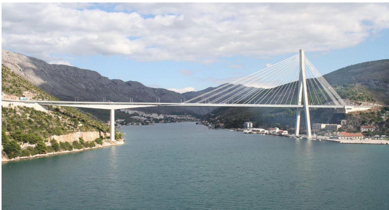
Slika 1: Pogled na most
