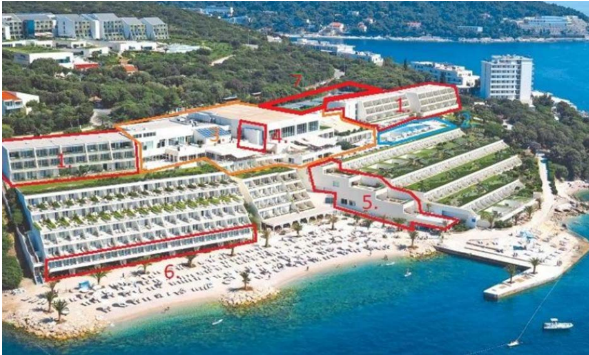
Slika 6. Shema izvedenih intervencija tijekom rekonstrukcije 2013. godine. D. Sošić: Rekonstrukcija hotela President u Dubrovniku 2013. godine, diplomski rad, Sveučilište u Rijeci, Građevinski fakultet, Rijeka, 2020.
