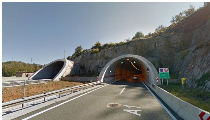
Slika 1. Prikaz portala desne cijevi tunela Grič, smjer Zagreb-Split [9]
