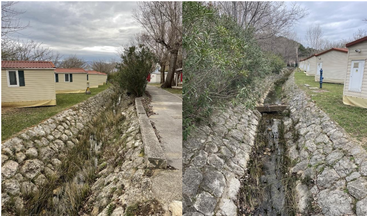
Slika 19: Pogled uzvodno i nizvodno uređenog dijela korita. (Slika autora 26.03.2023.)
