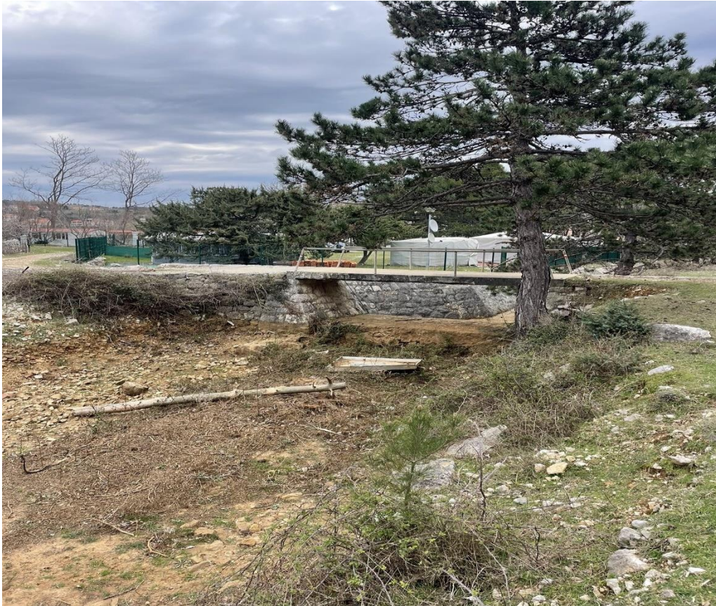
Slika 14: Armiranobetonski most i poprečni objekt, pogled nizvodno. (Slika autora 26.03.2023.)
