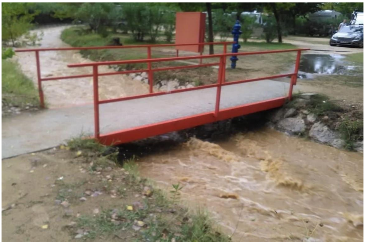
Slika 22: Turbulentno tečenje vode, pogled uzvodno. (Slika autora 15.08.2020.)
