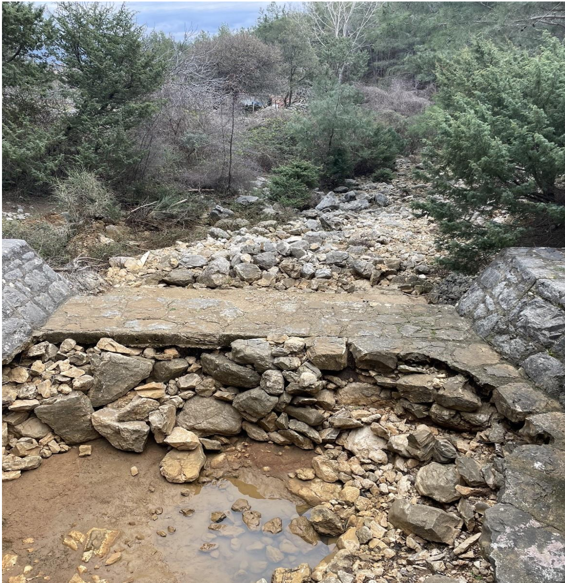
Slika 9: Poprečni objekt za zadržavanje nanosa, pogled nizvodno. (Slika autora 26.03.2023.)
