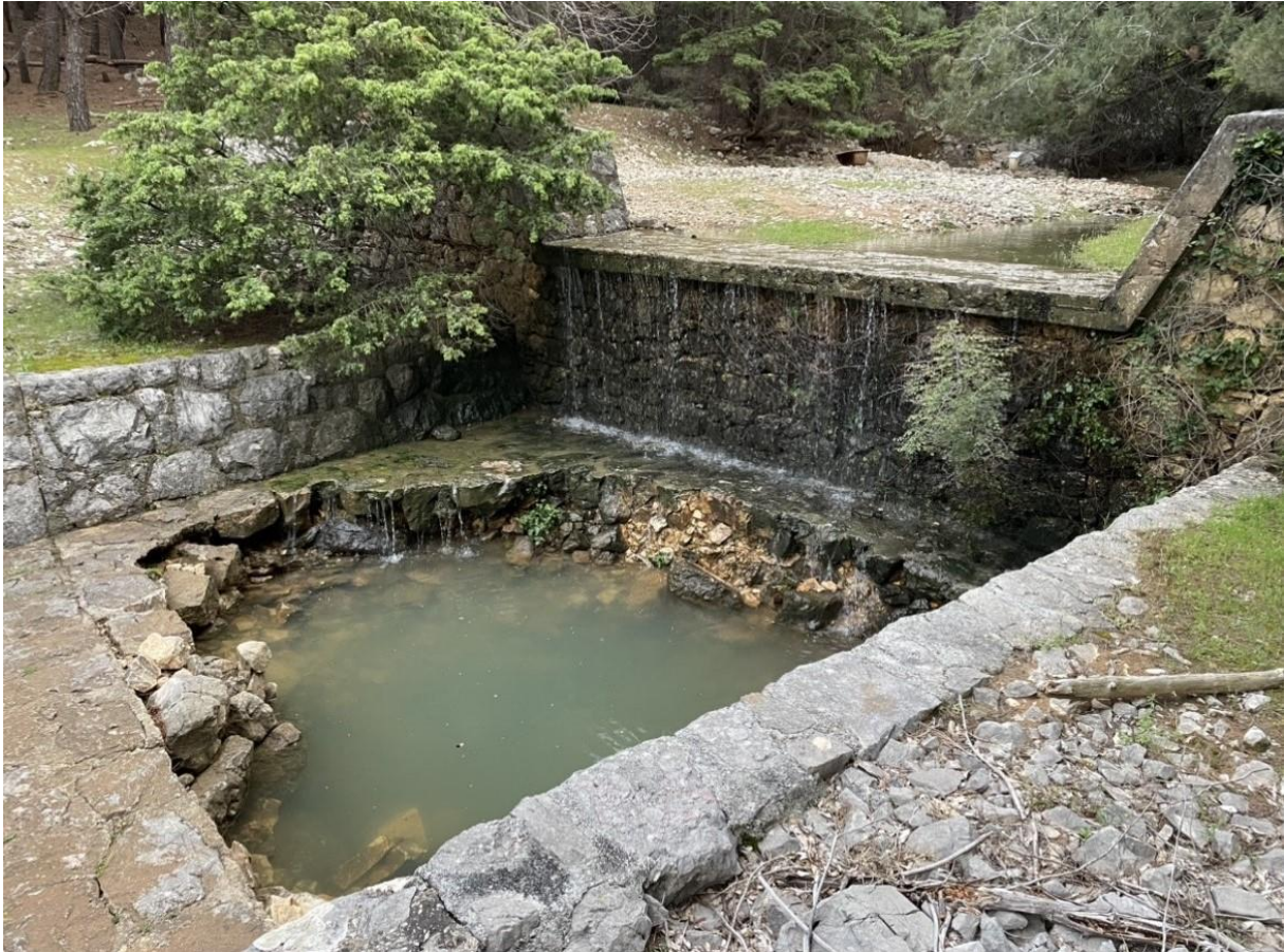
Slika 8: Poprečni objekt na gornjem djelu korita za zadržavanje nanosa. (Slika autora 05.09.2022.)
