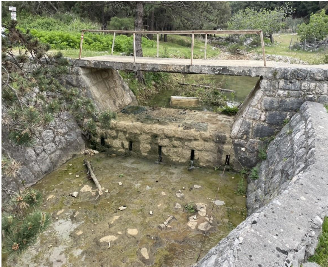
Slika 15: Armiranobetonski most i poprečni objekt, pogled uzvodno. (Slika autora 26.03.2023.)
