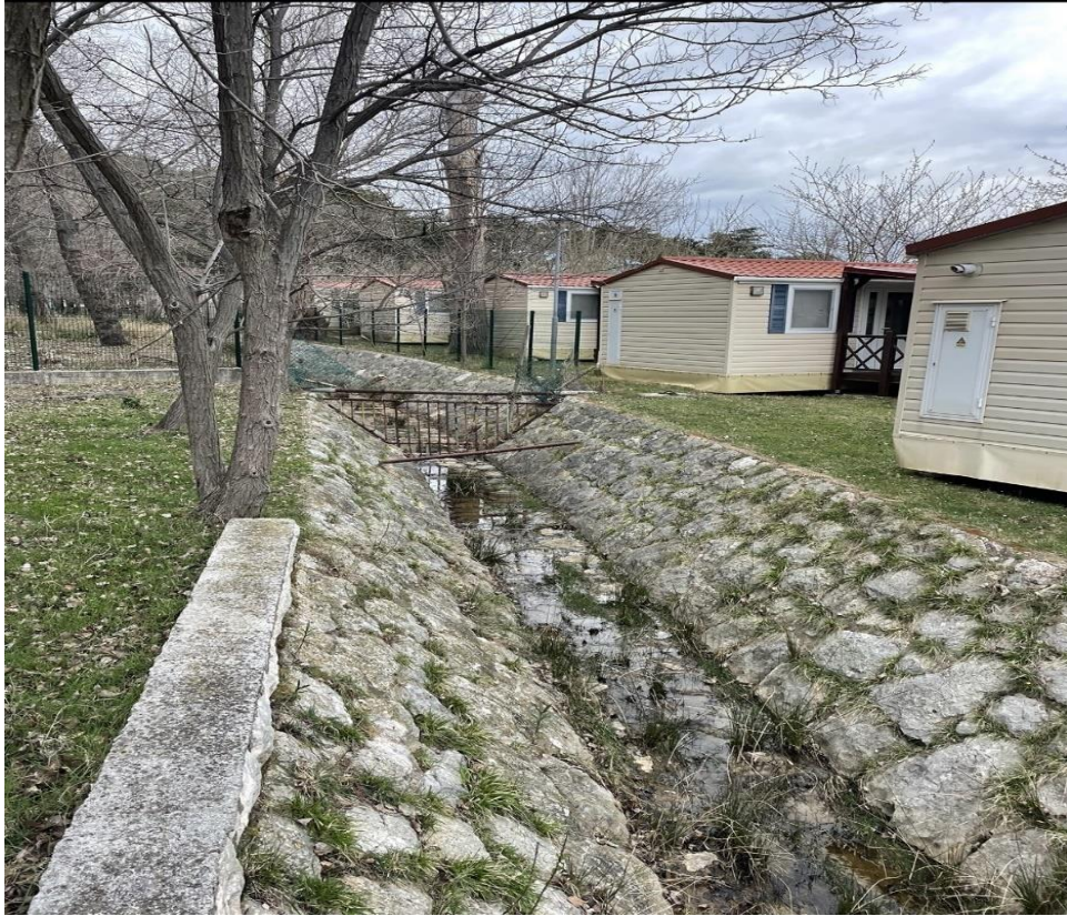
Slika 18: Uređeno korito bez protoka vode, pogled uzvodno. (Slika autora 26.03.2023.)
