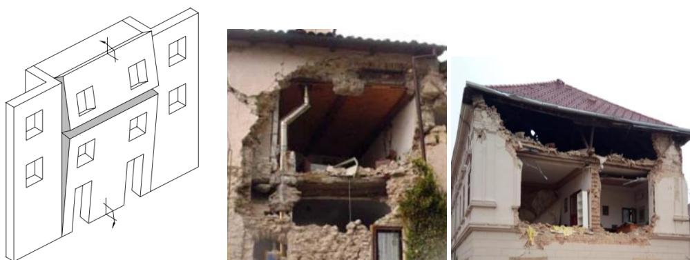
Slika 12. Formiranje vertikalnog luka: shema [2], primjeri [1,7]
