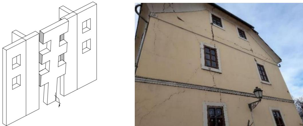
Slika 10. Prevrtanje vertikalne trake: shema [2] , primjer [4]
