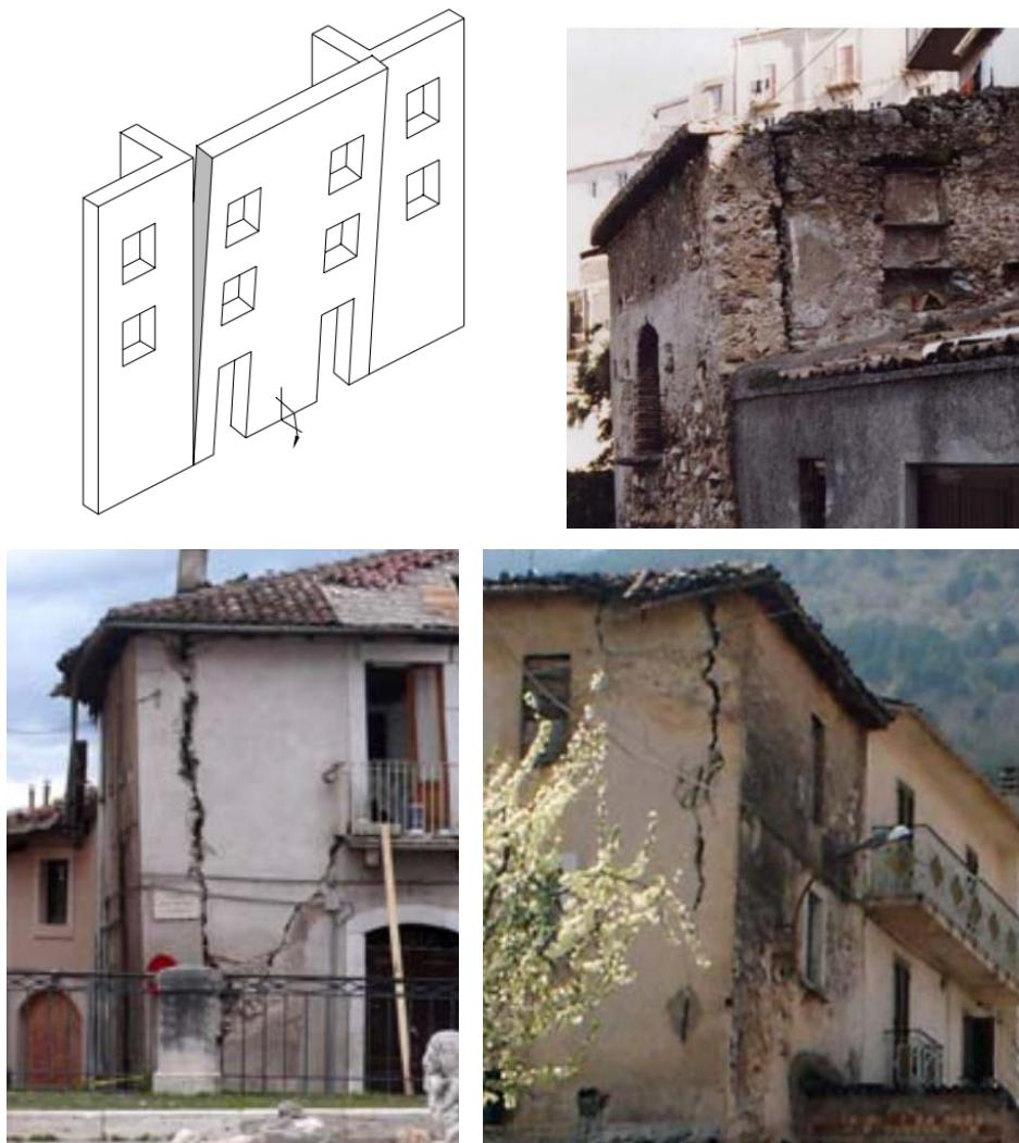
Slika 2. Prevrtanje zida pročelja: shema [2], primjeri [1]
