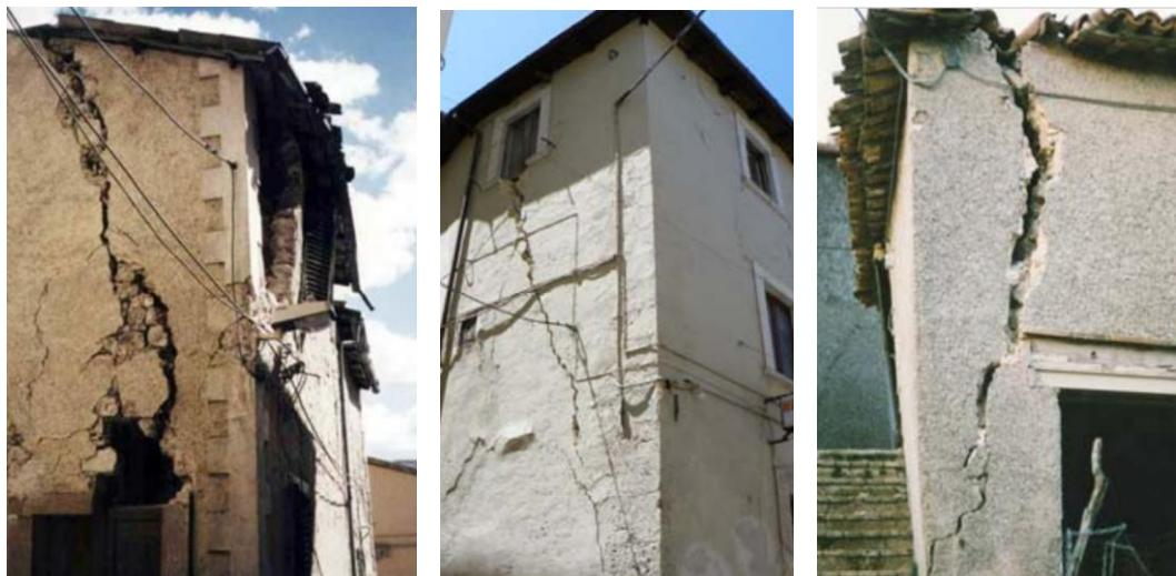
Slika 4. Prevrtanje zida pročelja s bočnim dijelom zida [1]
