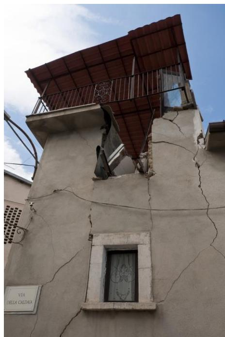
Slika 11. Prevrtanje vertikalne trake [10]
