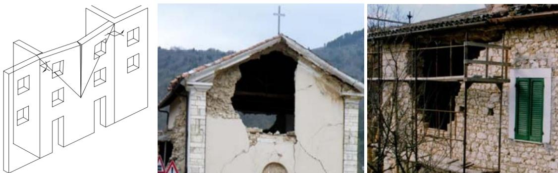
Slika 13. Formiranje horizontalnog luka: shema [2], primjeri [1]
