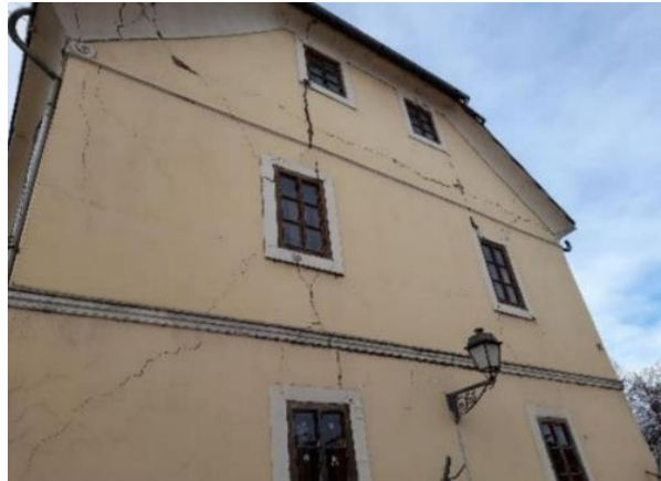
Slika 10. Prevrtanje vertikalne trake: shema [2] , primjer [4]
