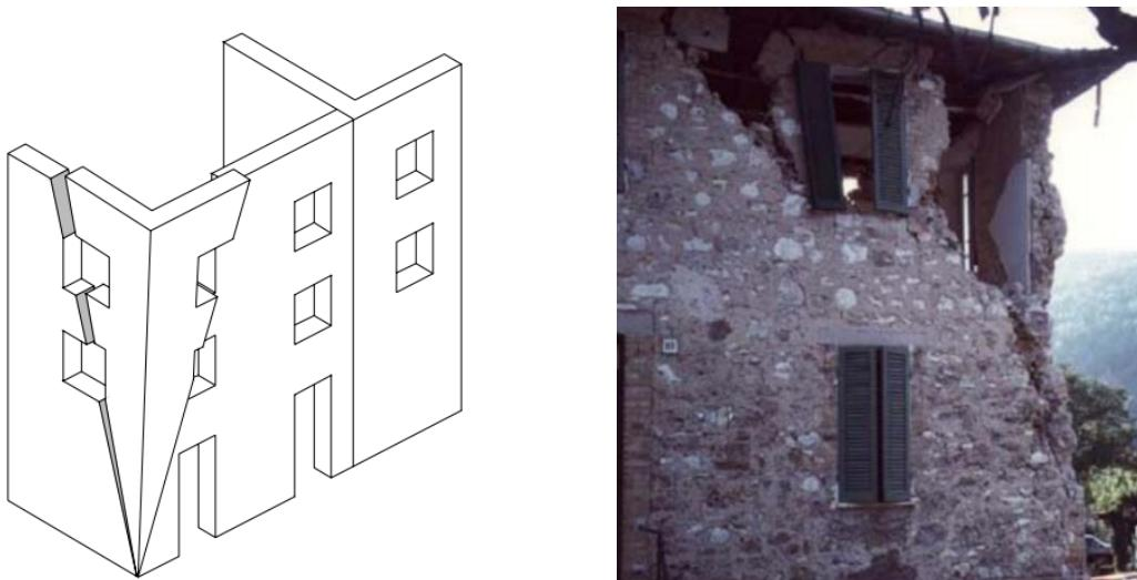
Slika 5. Slom ugla zida: shema [2], primjer [1]
