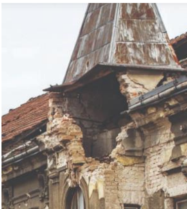
Slika 6. Slom ugla nakon potresa u Petrinji 2020.godine [8,10]
