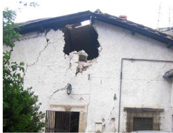
Slika 18. Prevrtanje lastavice zabata: shema [2], primjer [1]
