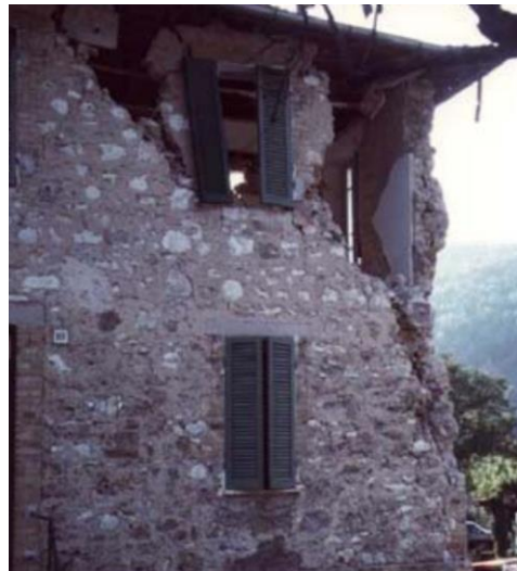
Slika 5. Slom ugla zida: shema [2], primjer [1]
