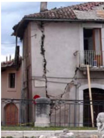
Slika 2. Prevrtanje zida pročelja: shema [2], primjeri [1]
