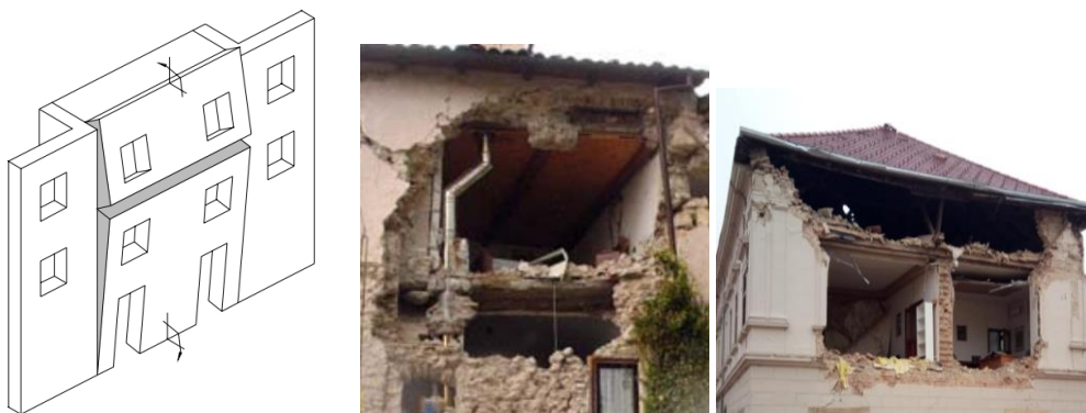
Slika 12. Formiranje vertikalnog luka: shema [2], primjeri [1,7]
