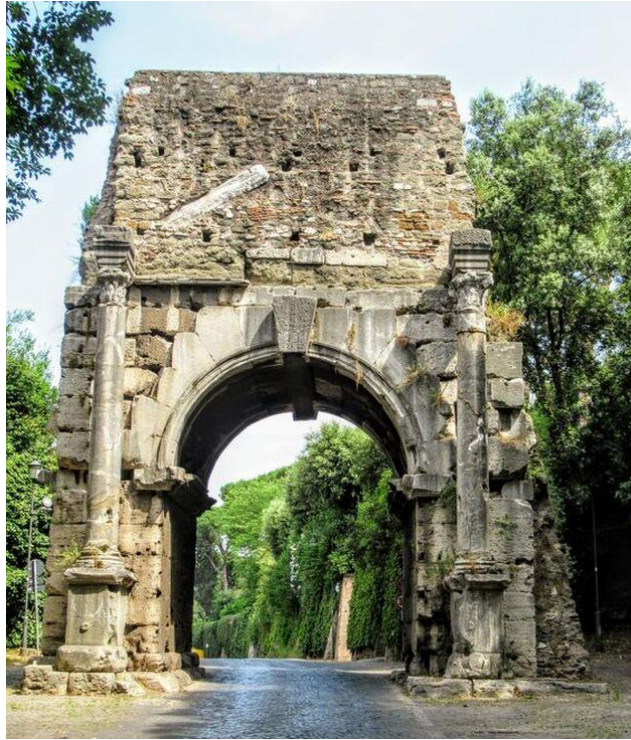
Slika 8: The arch of Drusus, Italija – primjer luka s 13 blokova [14]
