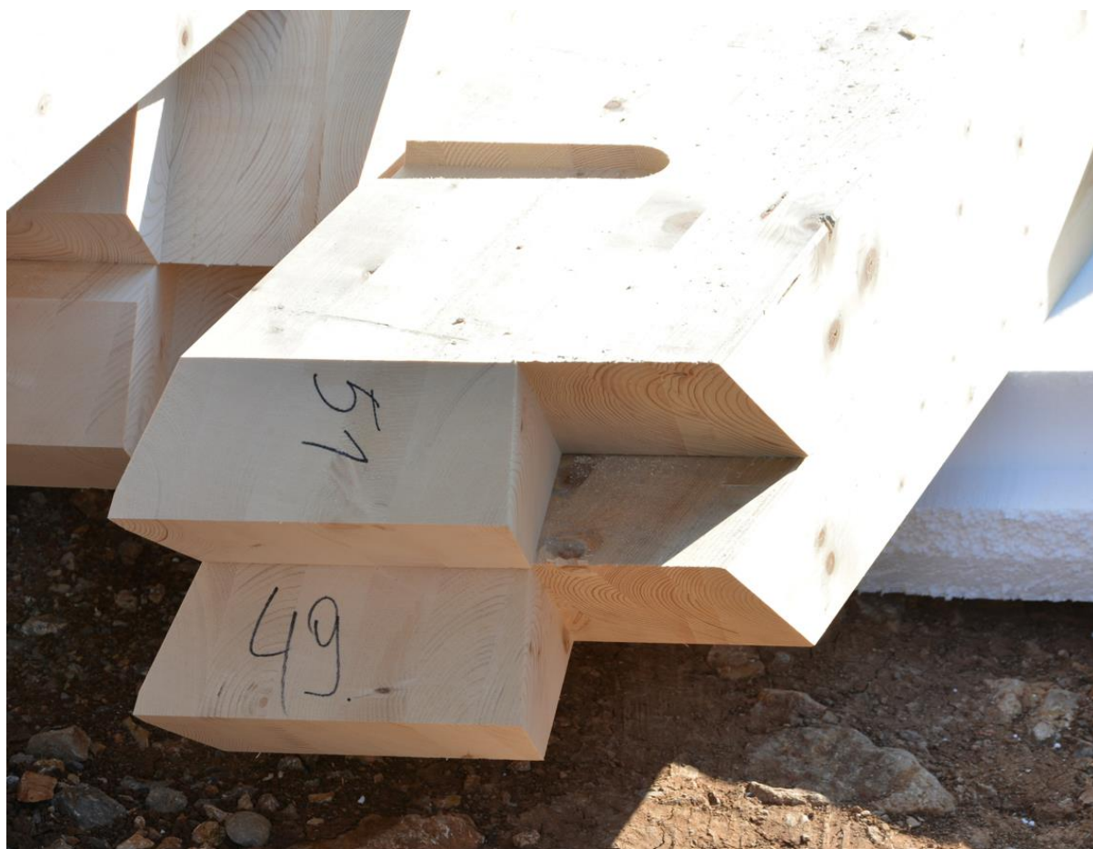
Slika 14 Označeni spojevi – Slaganje u sustavu frame
