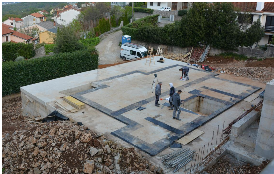
Slika 13 Čišćenje površine – Slaganje u sustavu frame
