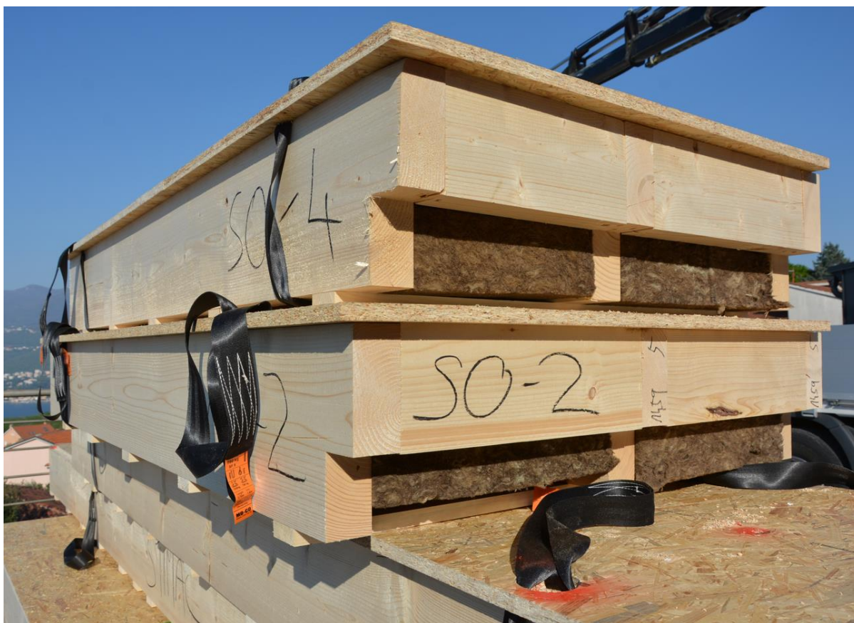
Slika 15 Dopremljeni paneli na gradilištu spremni za ugradnju – Slaganje u sustavu frame
