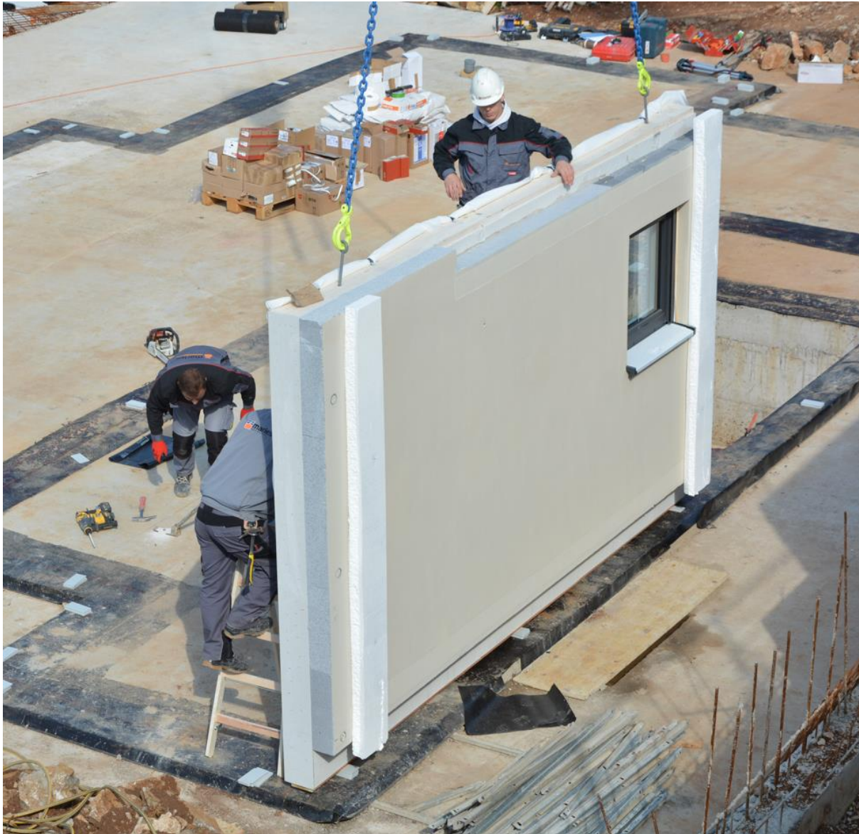
Slika 8 Učvršćivanje panela - Slaganje u sistemu frame
