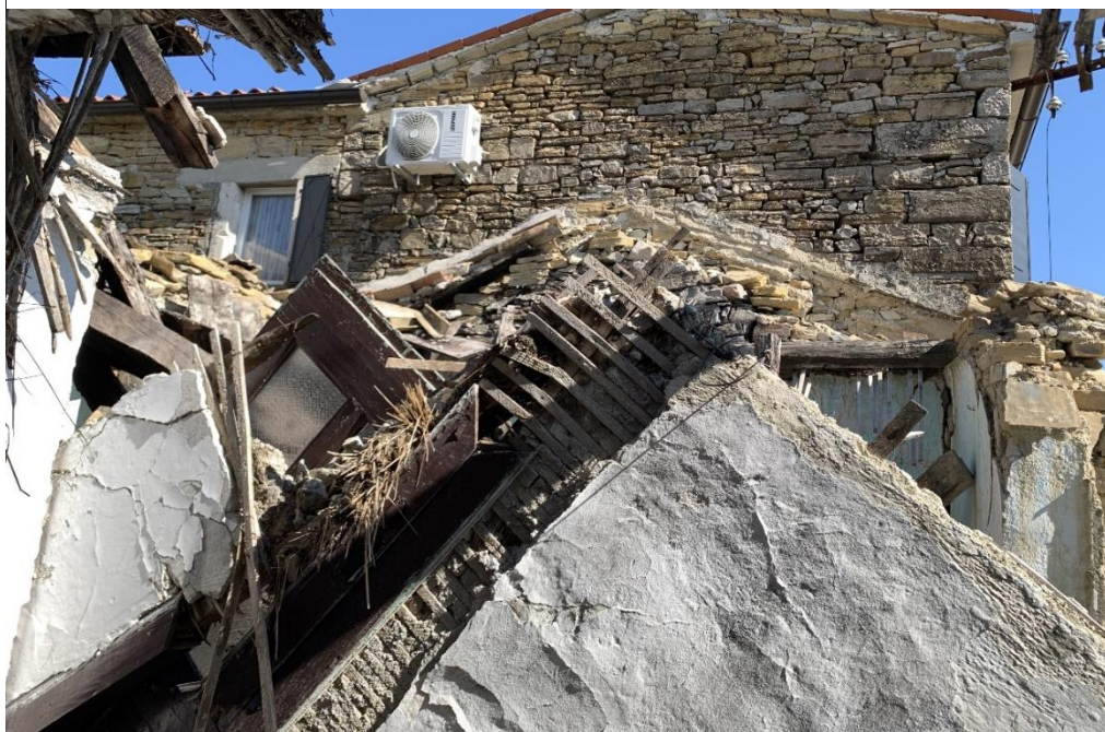
Slika 11 Postojeće stanje objekta
