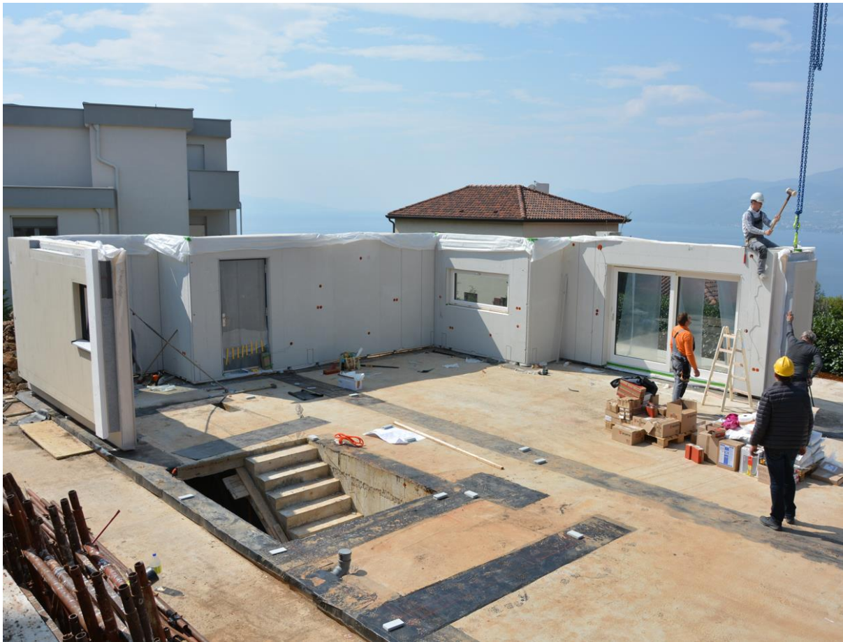
Slika 9 Slaganje zidova – Slaganje u sistemu frame
