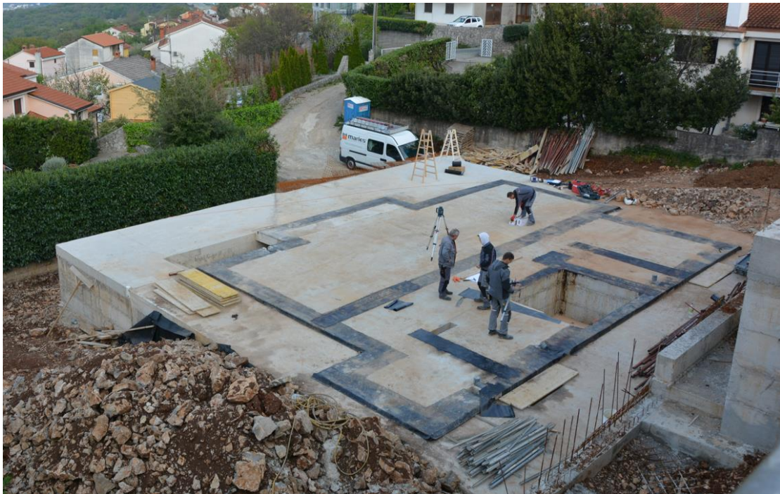
Slika 13 Čišćenje površine – Slaganje u sustavu frame
