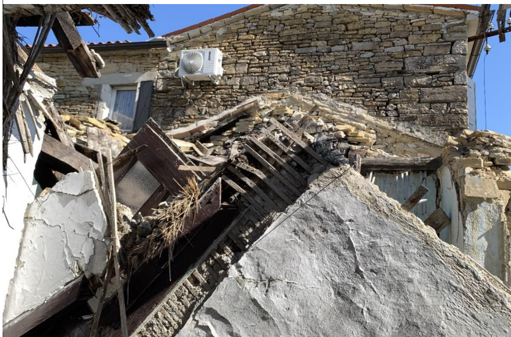
Slika 11 Postojeće stanje objekta
