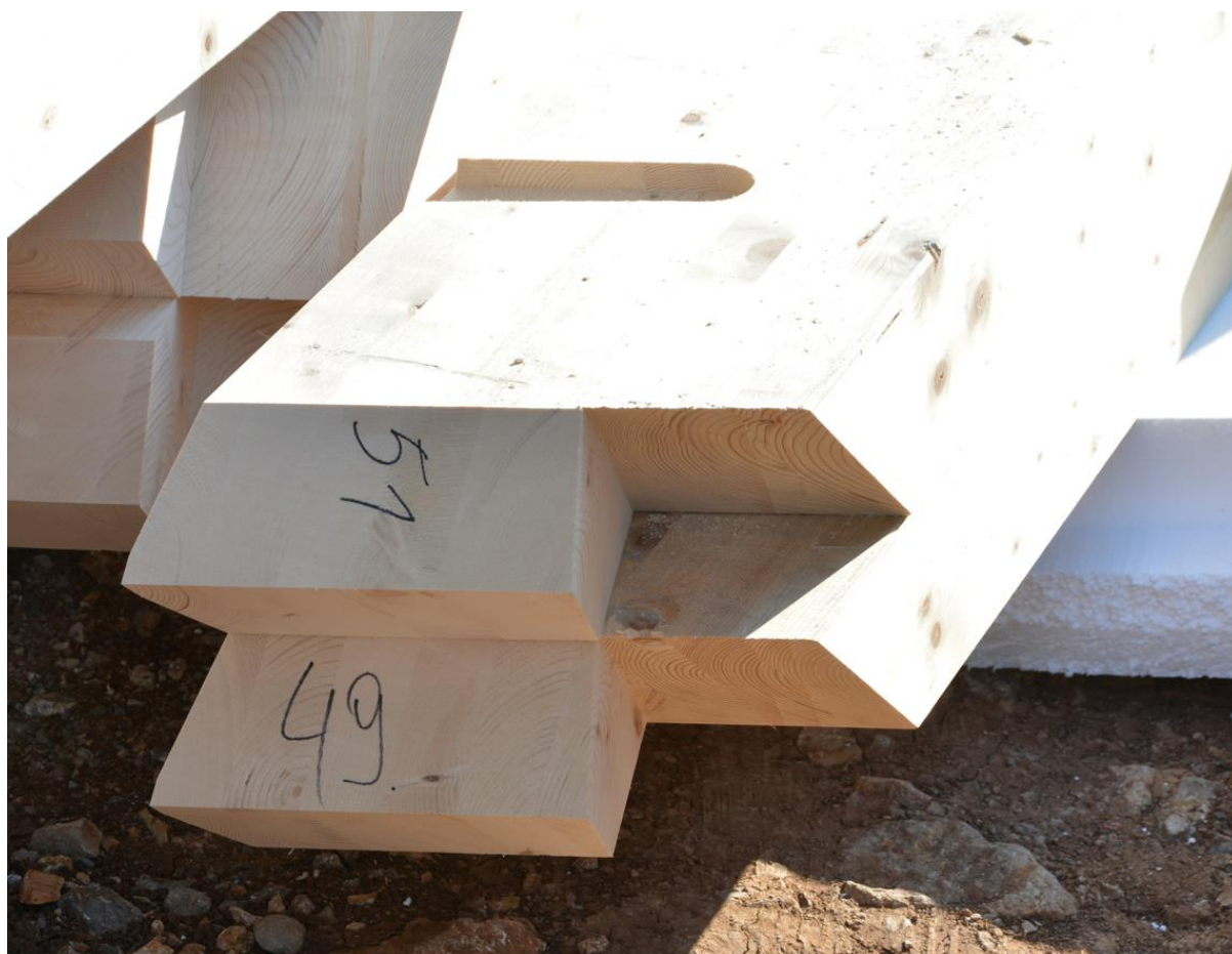
Slika 14 Označeni spojevi – Slaganje u sustavu frame
