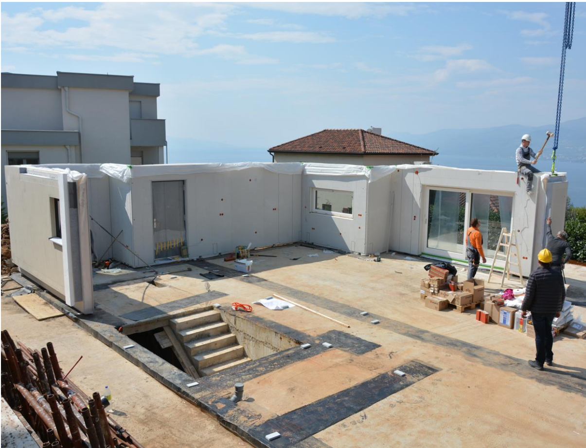
Slika 9 Slaganje zidova – Slaganje u sistemu frame
