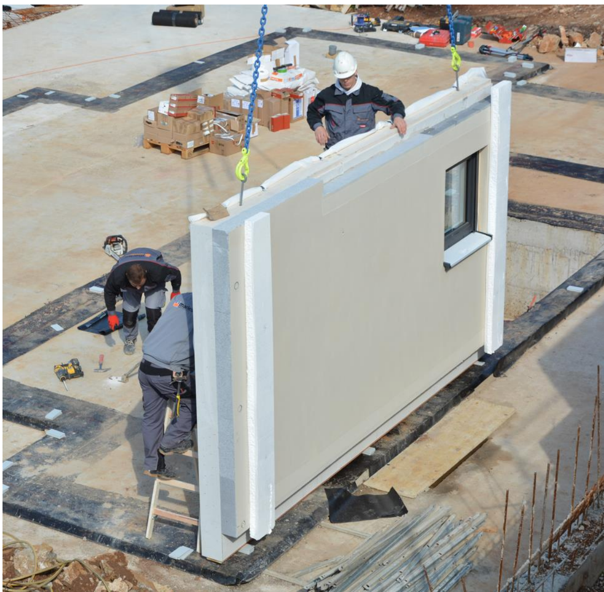
Slika 8 Učvršćivanje panela - Slaganje u sistemu frame
