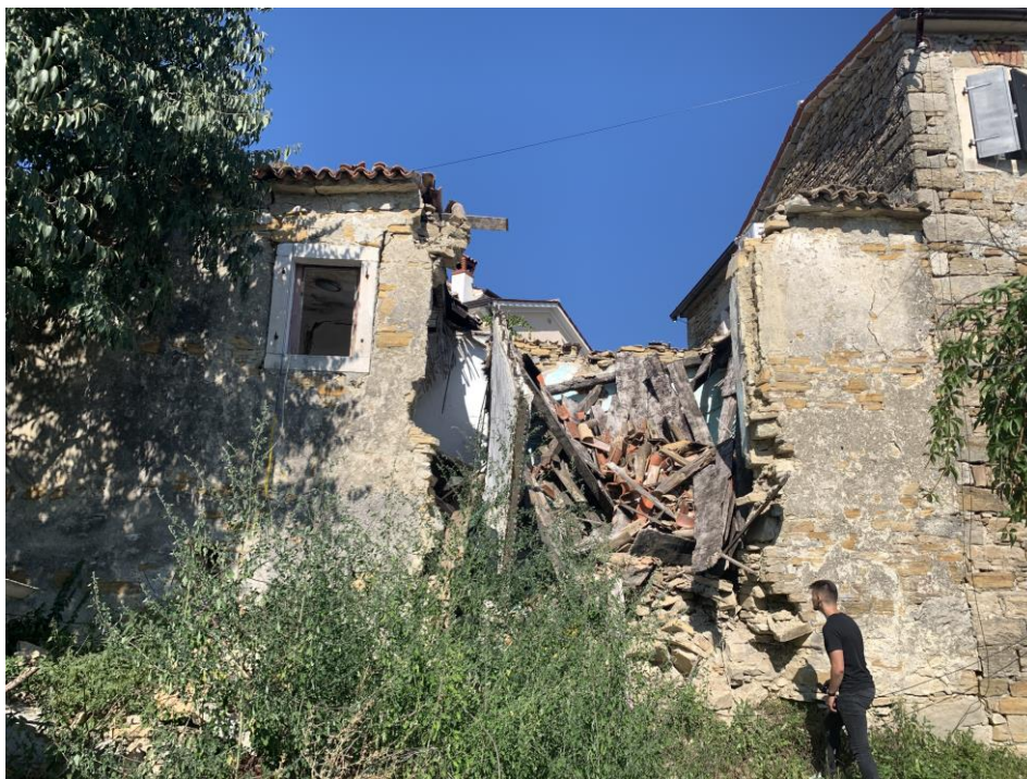
Slika 10 Postojeće stanje objekta
