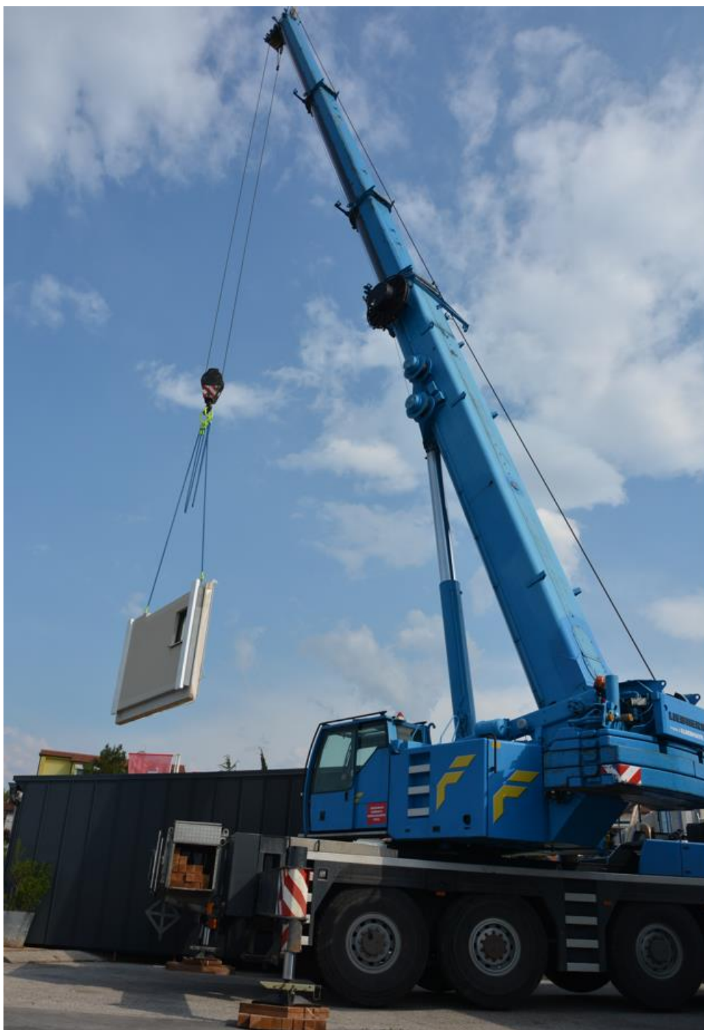
Slika 6 Podizanje panela - Slaganje u sistemu frame
