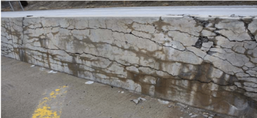
Slika 5: Barijera na autocesti napadnuta alkalnom reakcijom [6]
