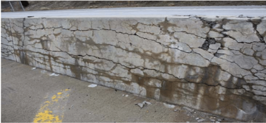
Slika 5: Barijera na autocesti napadnuta alkalnom reakcijom [6]
