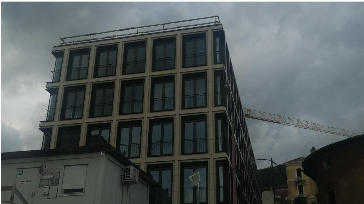
Slika 22: Hotel Keight u izgradnji (foto autor, 2023.)
