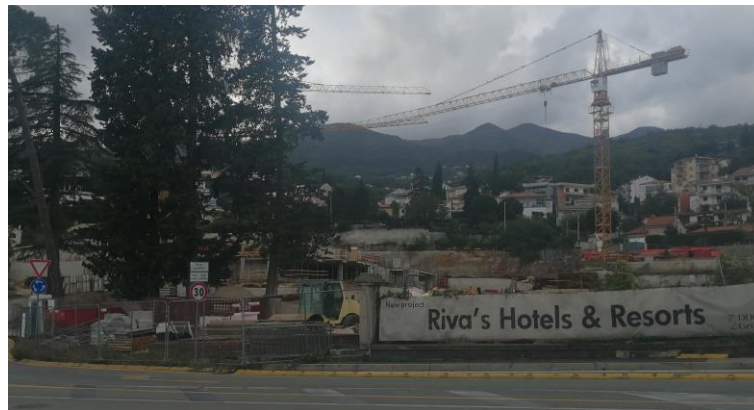
Slika 21: pogled na gradilište hotela Marriot, Ičići (foto autor, 2023.)
