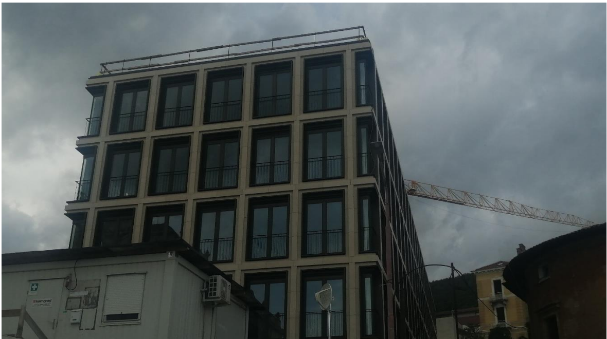
Slika 22: Hotel Keight u izgradnji (foto autor, 2023.)
