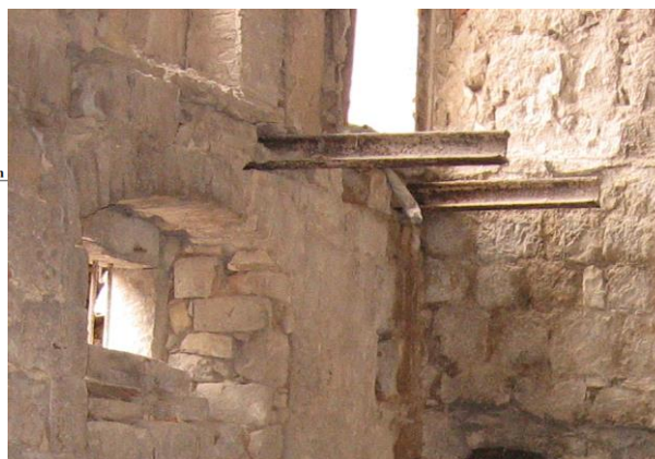
Slika 32: Detalj podupiranja čeličnim nosačima (osobna arhiva) 200
