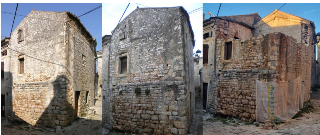
Slika 38: Južno pročelje građevine u ul. Borgo 26, Bale-Valle 234
