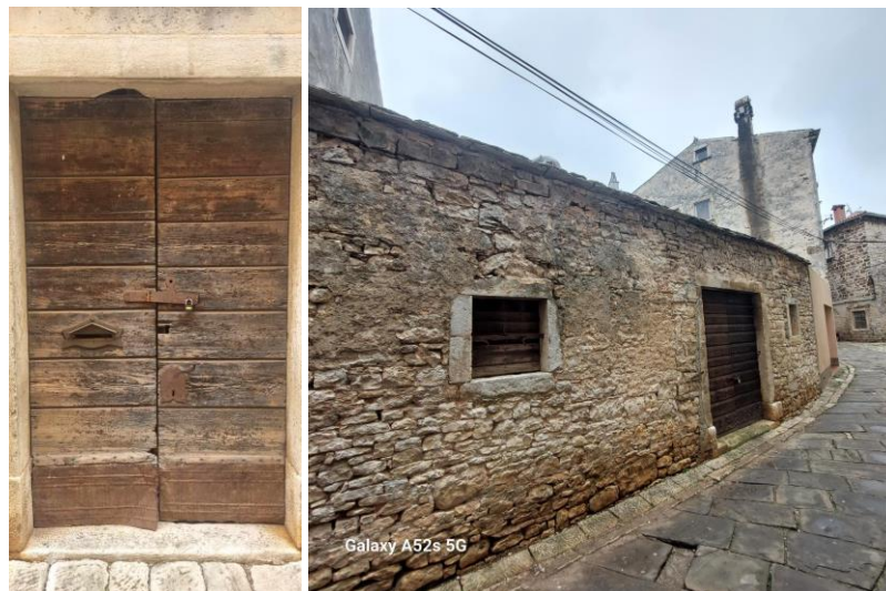
Slika 16: Ulazna i dvorišna vrata, Vodnjan (foto autorica, 2023.)
