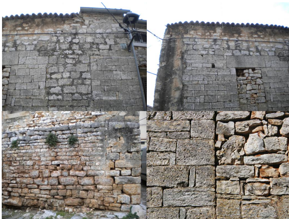
Slika 41: Postojeći zidovi na predmetnoj građevini (osobna arhiva, 2022.)
