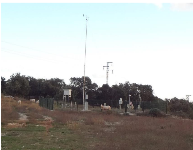
Slika 3.1.2. Automatska klimatološka postaja Vransko jezero-Cres (izradio autor)
