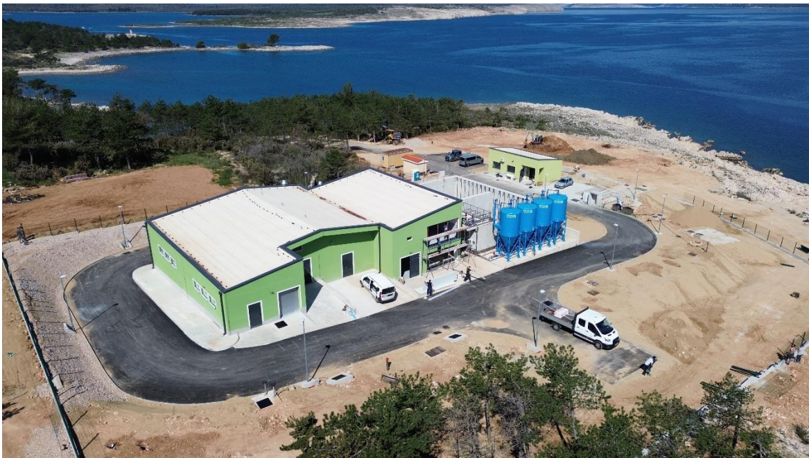
Slika 31. Prikaz UPOV-a prilikom završetka radova [15]
