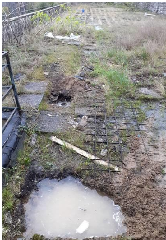
Slika 67 Prikaz zadržavanja vode na ploči terase [13]
