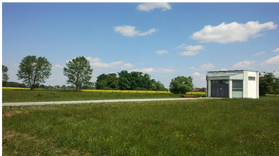
Slika 9. Vodocrpilište u Delovima [5]
