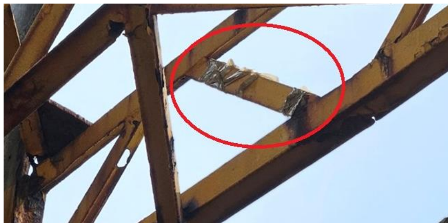
Slika 10: Pozicija elementa br. 1 na konstrukciji
