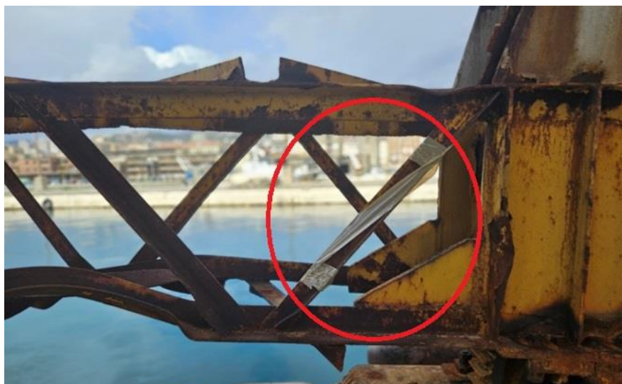
Slika 11: Pozicija elementa br. 2 na konstrukciji
