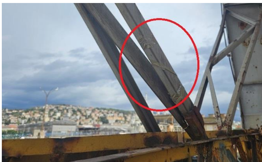
Slika 12: Pozicija elementa br. 3 na konstrukciji
