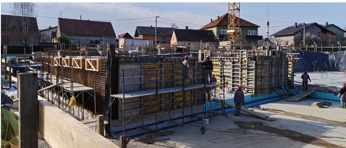
Slika 12. Postavljanje skele oko zidova podruma
