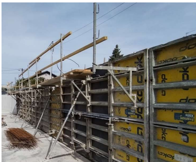
Slika 13. Postavljanje skele na oplatni sistem "Doka"
