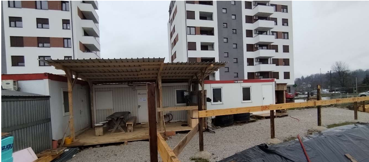
Slika 11. Građevinski kontejneri za boravak radnika
