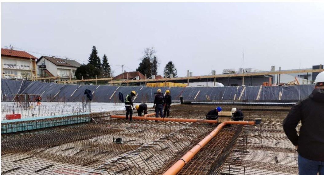
Slika 9. Postavljanje armaturne mreže u temeljnu ploču
