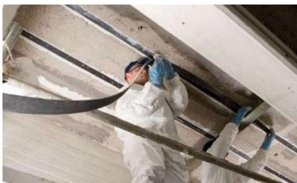
Slika 30: Postavljanje FRP lamela 70
