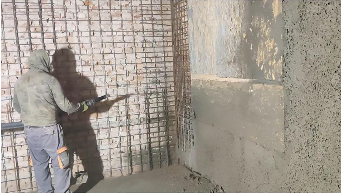
Slika 14: Nabacivanje mlaznog betona 51
