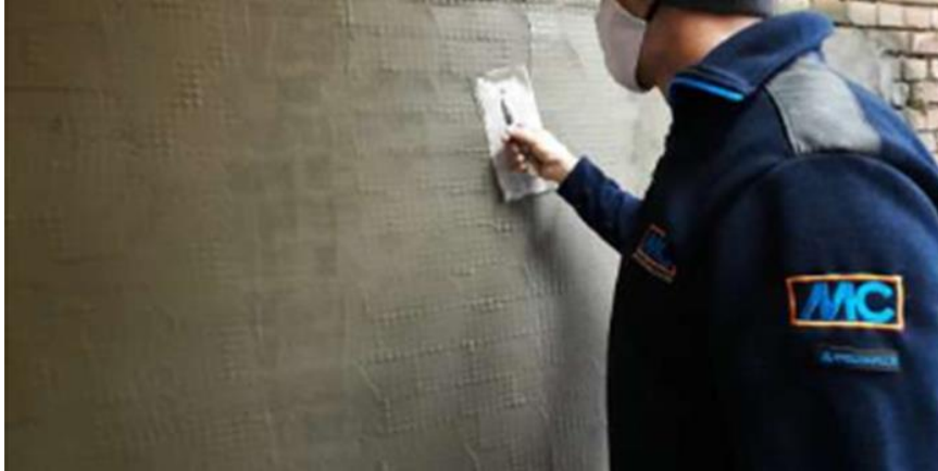
Slika 27 : Nanošenje drugog sloja morta na zid 68
