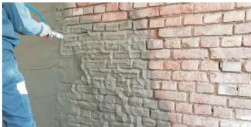
Slika 25 : Nanošenje prvog sloja morta na pripremljeni zid 66
