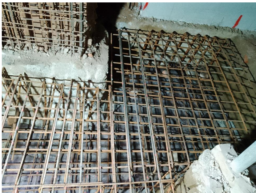
Slika 5: Armaturni koš u jami za temelj (foto autorica, 2023.)
