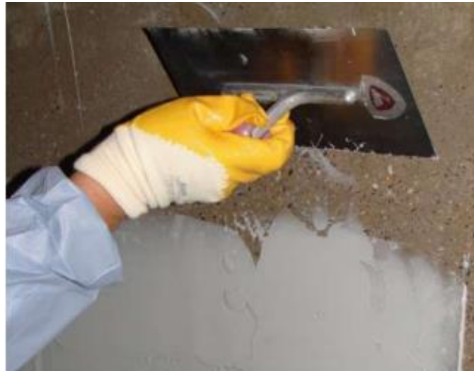
Slika 31: Ravnanje podloge mortom 73
